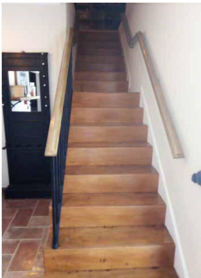
↑ Obra: Escadas e Corrimão // Produtos: Corrimão: Subcapa PU TIX, Verniz Probex Aquoso TD 290 Câmbara, Verniz Aquataco Incolor | Escadas: Verniz Aquataco Mate TD 293 Pinho Mel, Verniz Aquataco Incolor
