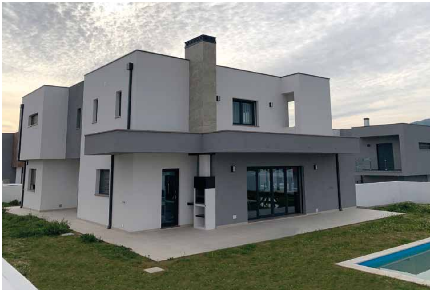
↑ Obra: Moradia Familiar // Localidade: Quinta da Grila - Covilhã // Produtos: Fachada: Sistema ThermInnov // Cliente: Construções Francisco & Vicente // Comercial: Joaquim Chaves
