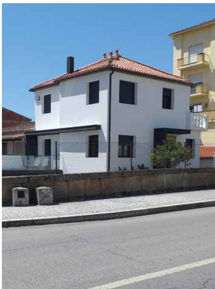
↑ Obra: Moradia Familiar // Localidade: Valpaços // Produtos: Fachada: Sistema ThermInnov, Crepimil Extra R15 Branco e RAL 7016 // Cliente: Abel Ribeiro // Aplicador: José Manuel Coelho // Comercial: Marco Cardoso
