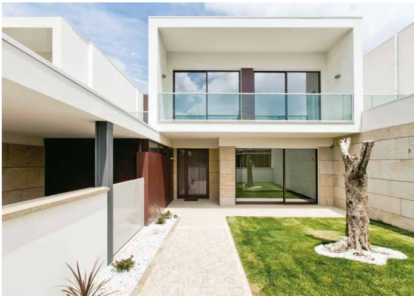
↑ Obra: Moradia Familiar // Localidade: Vila Flor - Braga // Produtos: Fachada: Sistema ThermInnov | Cornija: Primário Pliomil, Tinta Acrílica Pura 9G | Interior: Primário Pliomil Aquoso, Plasmate // Cliente: Sá Taqueiro // Comercial: Manuel Fernandes
