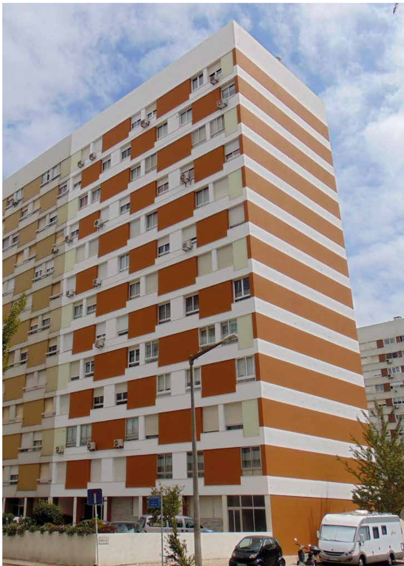
↑ Obra: Prédio Habitacional // Localidade: Lisboa // Produtos: Fachada: Isolante Betonilha, Tinta Texturada CC, Plas Super // Cliente: Zoli Unipessoal, Lda. // Comercial: António Franco
