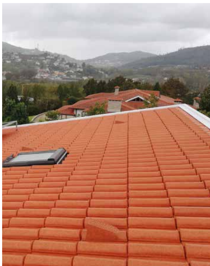
↑ Obra: Telhado // Localidade: Felgueiras // Produtos: Limpalina, Hidrofugante Aquoso Telhas // Cliente: António Lopes // Comercial: Tiago Fernandes
