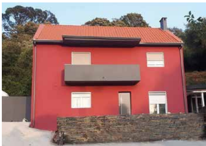
↑ Obra: Moradia Familiar // Localidade: Lisboa // Produtos: Fachada: Sistema ThermInnov, Tinta Texturada CC, Tinta Acrílica Pura 9G // Cliente: Planeta Salteado Comercial: Luís Alves
