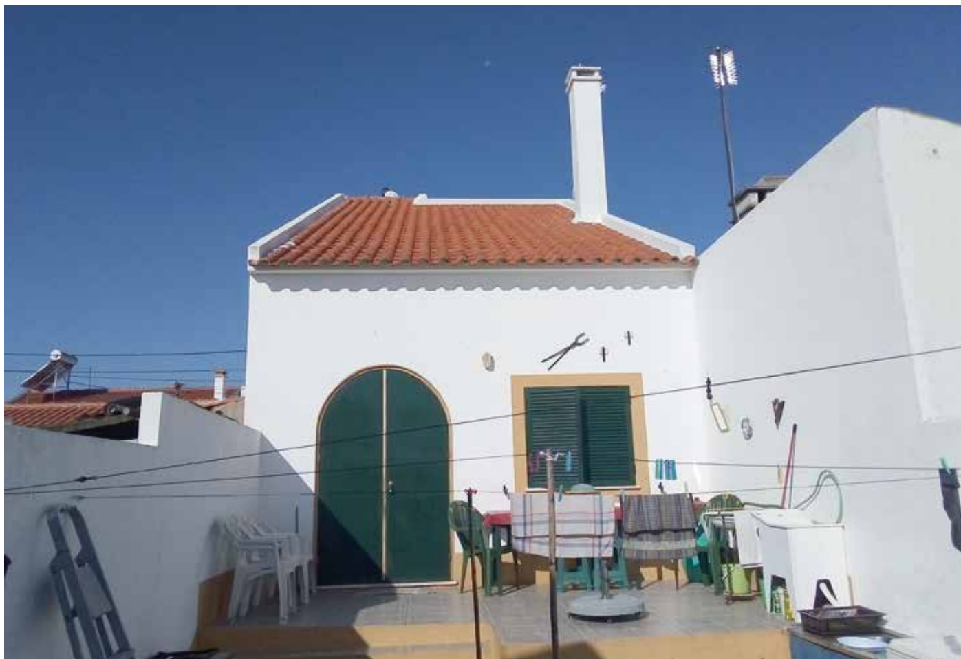
↑ Obra: Telhado // Localidade: Évora // Produtos: Telhado: Limpamil, Hidrofugante Aquoso Telhas // Cliente: Particular // Comercial: Vitor Neto
