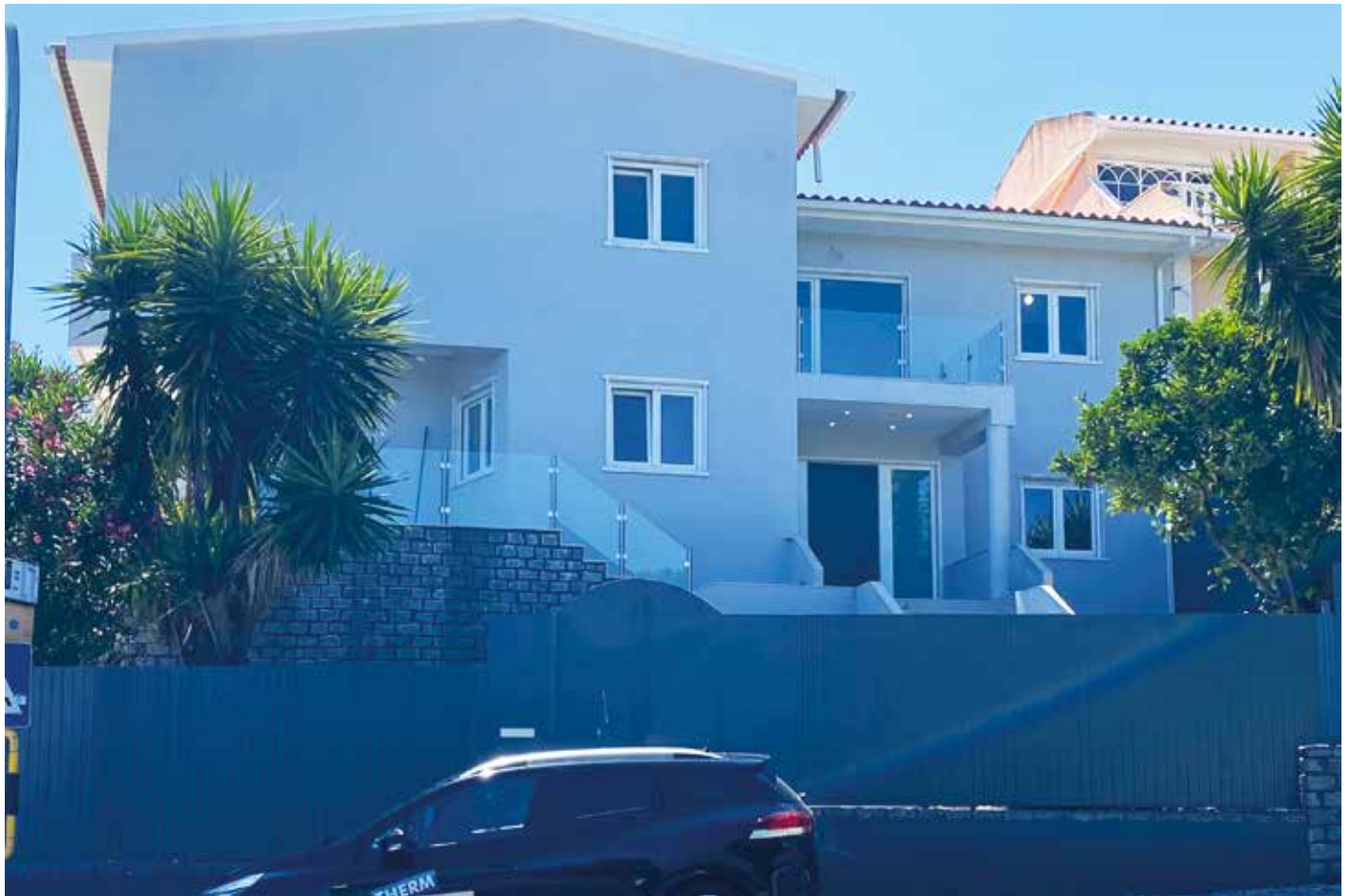
↑ Obra: Moradia Familiar // Localidade: Carnaxide // Produtos: Fachada: Argamassa Thermlnnov 2009, Primário Lamurite Aquoso, Tinta Acrílica Pura 9G Branco e Cor | Gradeamento: Primário Policril, Esmalte Policril // Cliente: Promovenda,Lda. // Comercial: Luís Alves
