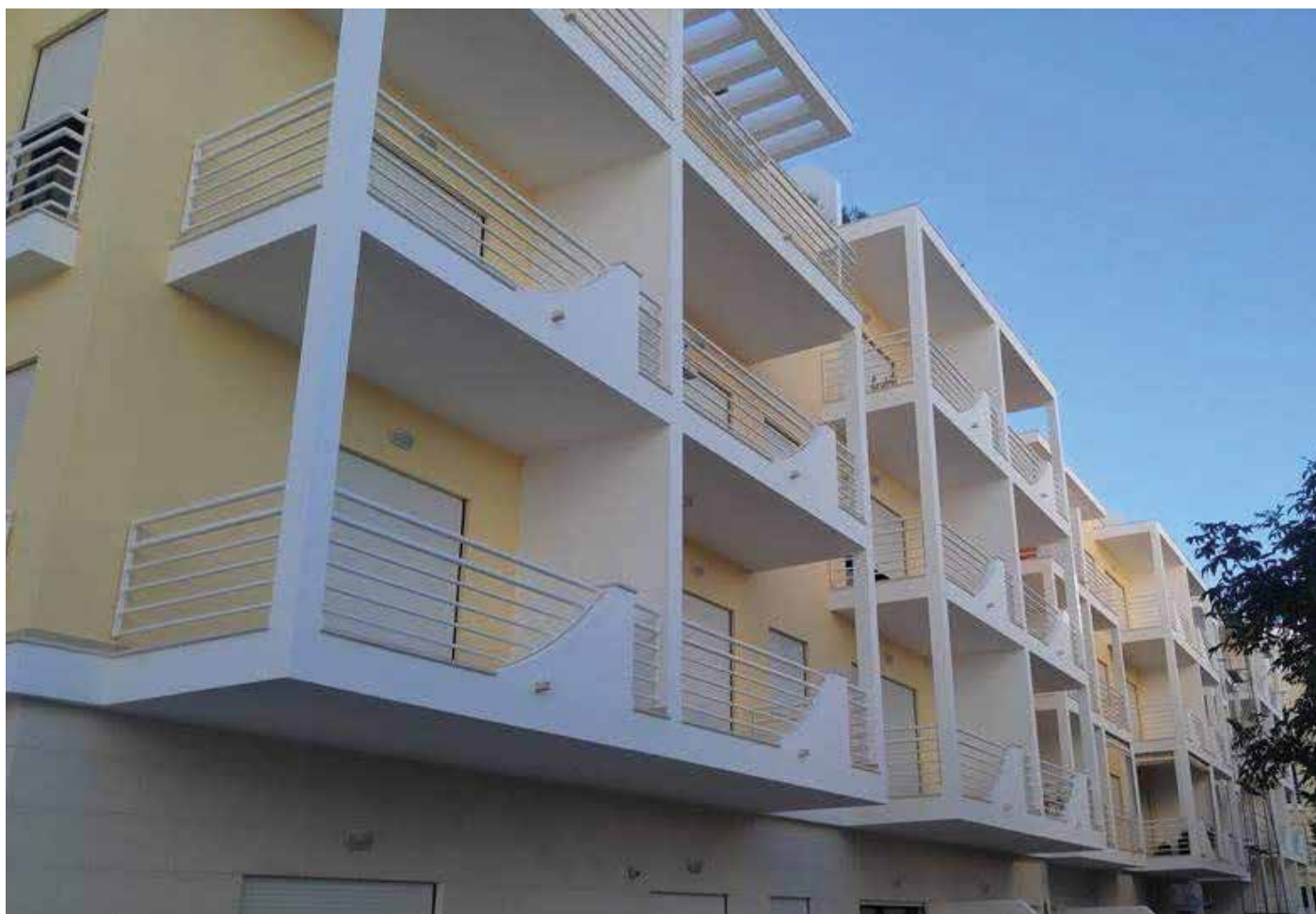
↑ Obra: Prédio Habitacional // Localidade: Alcabideche - Cascais // Produtos: Fachada: Primário Lamurite Aquoso, Tinta Texturada CC, Tinta Acrílica Pura 9G Cliente: Planeta Salteado // Comercial: Luís Alves
