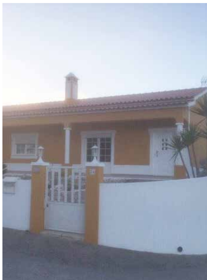
↑ Obra: Moradia Familiar // Localidade: Santarém // Produtos: Fachada: Isolante Betonilha, Argamassa ThermInnov 2009, Primário Isolina, Tinta Acrílica AD Microtex, Lináqua | Portão: Esmalte Policril // Cliente: TVM - Tintas, Máquinas e Vernizes, Lda. // Construtor: Construções Furão, Lda. Comercial: Tiago Medeiros
