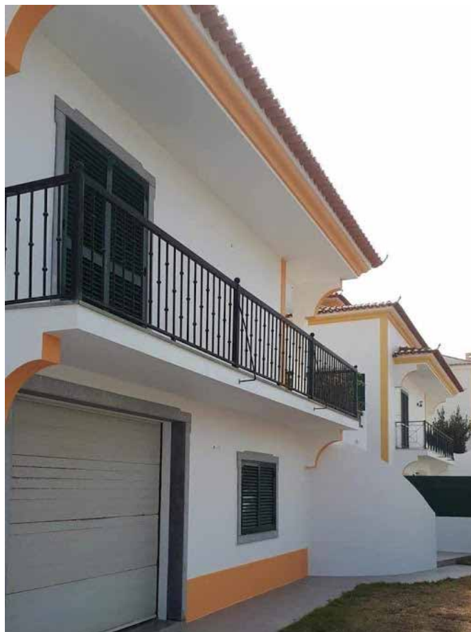
↑ Obra: Moradia Familiar // Localidade: Torres Vedras // Produtos: Fachada: Primário Lamurite PL Branco, Tinta Texturada CC, Tinta Acrílica Pura 9G Branco e Cor // Cliente: Freiripinta // Comercial: Luís Alves
