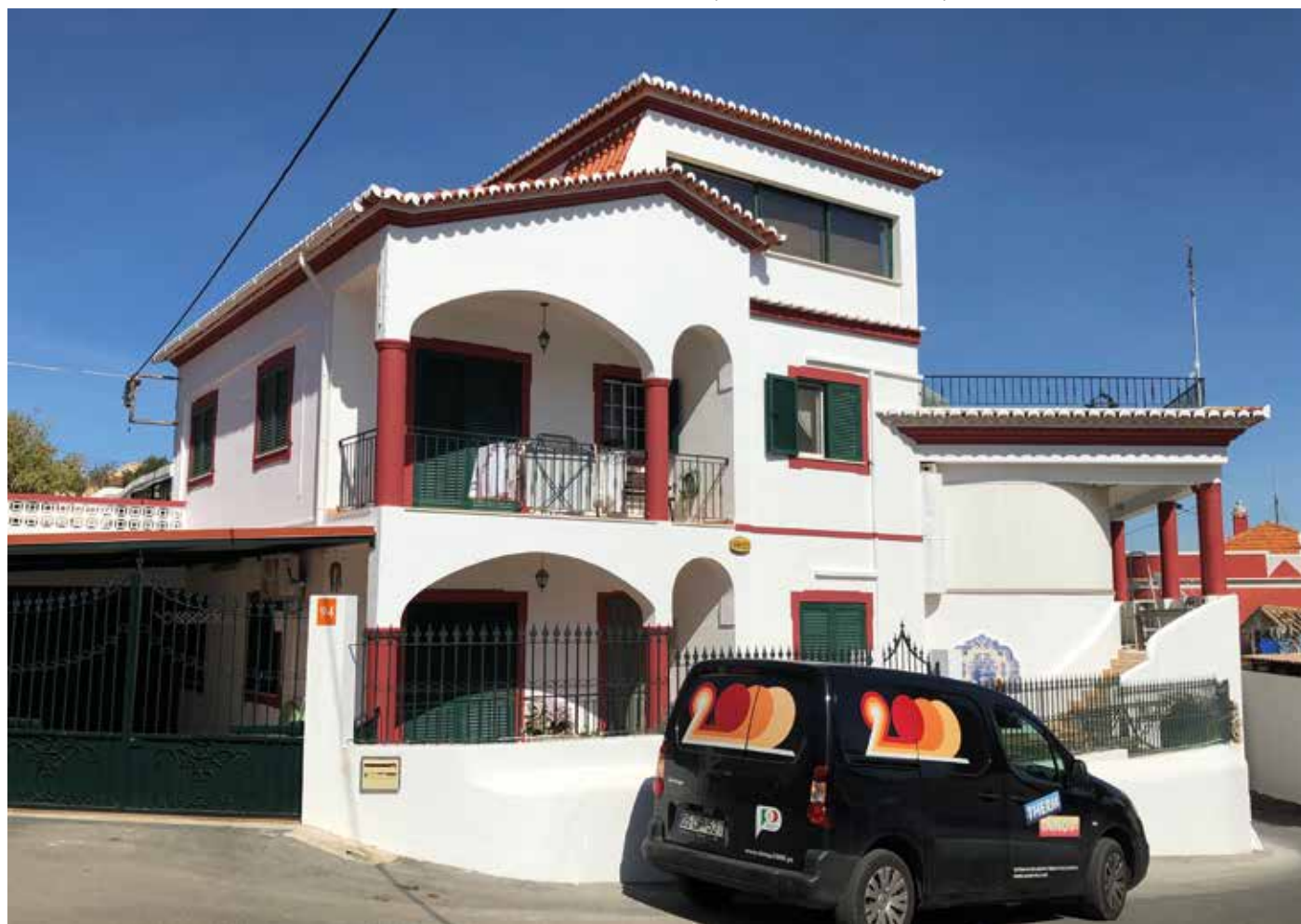
↑ Obra: Moradia Familiar // Localidade: Boliqueime // Produtos: Fachada: Argamassa Thermlnnov 2009 Branco, Primário Isoselante, Plas Super Branco e TD R861 Vermelho Óxido // Aplicador: António Sousa // Comercial: Hugo Silva
