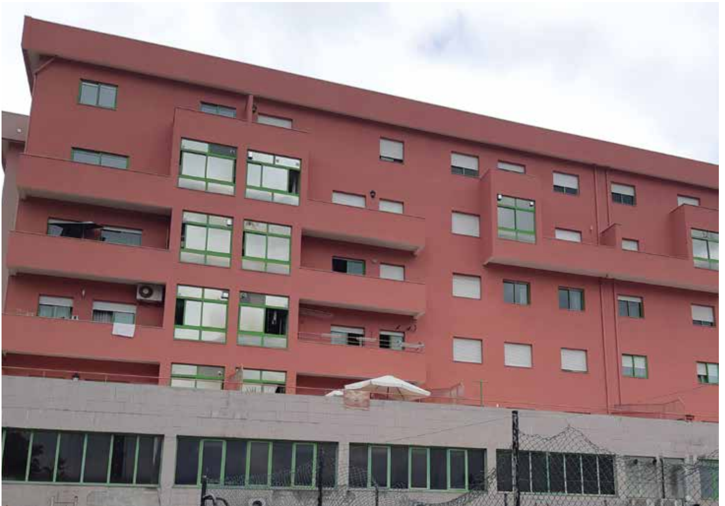
↑ Obra: Prédio Habitacional // Localidade: Paredes // Produtos: Fachada: Sistema ThermInnov // Cliente: Miguel Martins Carvalho, Lda. // Comercial: Hugo Mendes
