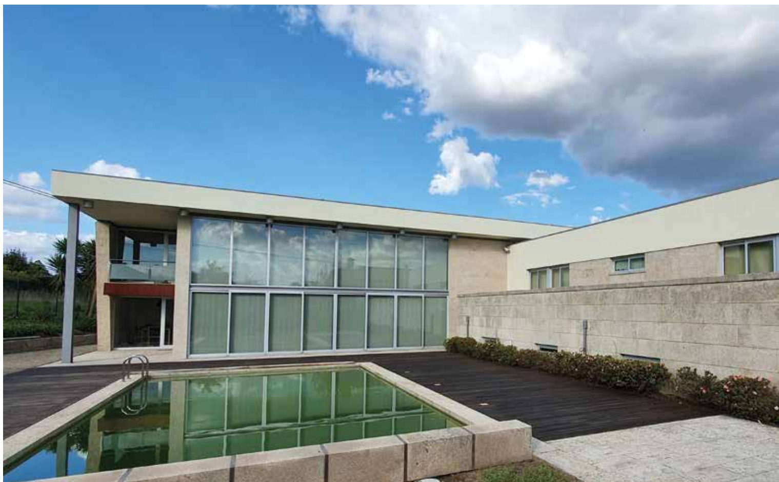
↑ Obra: Moradia Familiar // Localidade: Santo Tirso // Produtos: Fachada: Sistema ThermInnov, Crepimil Extra R12 | Ferro: Esmalte Forja | Madeira: Verniz Probex
