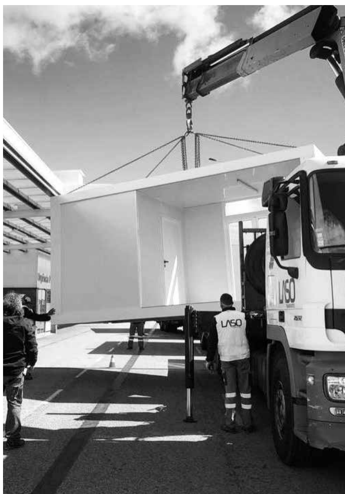
↑ Obra: Contendor // Localidade: S. Domingos de Rana - Cascais // Produtos: Esmalte Policril M/B Ral 9010 // Cliente: MBW - Modular Builders Worldwide, Lda. Comercial: Edgar Ribeiro
