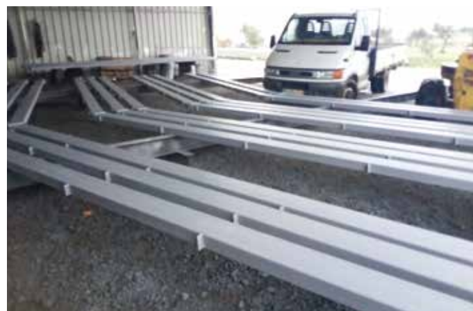
↑ Obra: Asnas de Ferro // Localidade: Estremoz // Produtos: Primário Epoximar // Cliente: José Malhadas // Comercial: Vitor Neto
