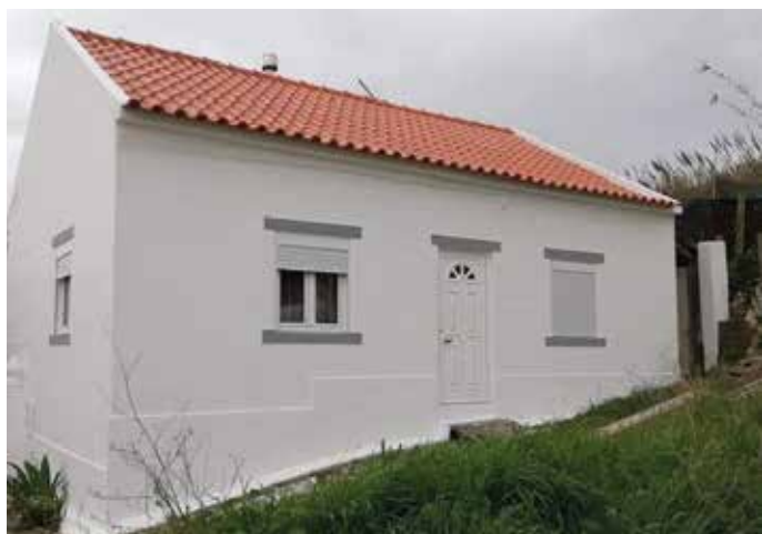
↑ Obra: Moradia Familiar // Localidade: Torres Vedras // Produtos: Fachada: Primário Lamurite Aquoso, Tinta Acrílica Pura 9G // Cliente: Freiripinta // Comercial: Luís Alves
