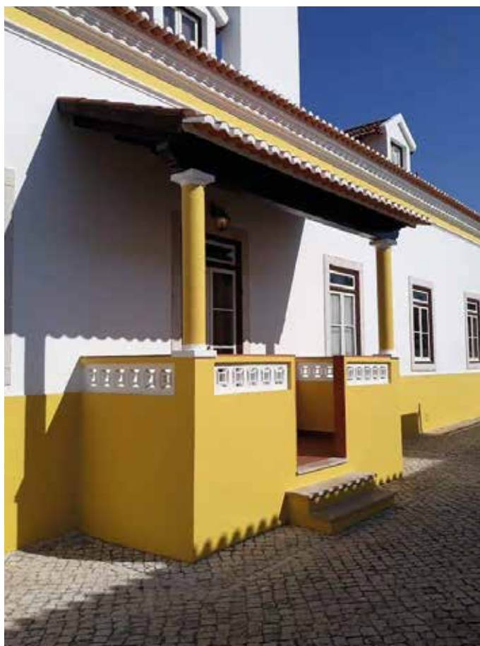
↑ Obra: Moradia Familiar // Localidade: Torres Vedras // Produtos: Fachada: Primário Lamurite Aquoso, Tinta Texturada CC, Tinta Acrílica Pura 9G // Cliente: Freiripinta // Comercial: Luís Alves
