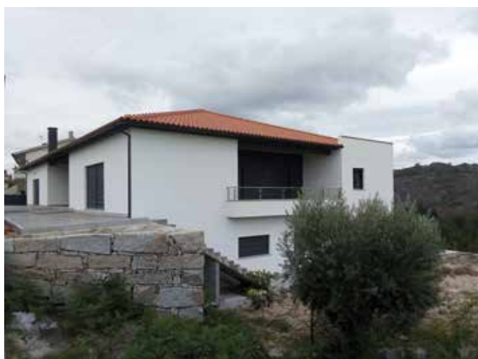
↑ Obra: Moradia Familiar // Localidade: Esmofe - Penalva do Castelo // Produtos: Abas: Primário Lamurite PL, Lináqua RAL 7024 | Fachada: Primário Isolina, Crepimil Extra R15 Branco // Cliente: José Almeida Melo // Comercial: António Sousa
