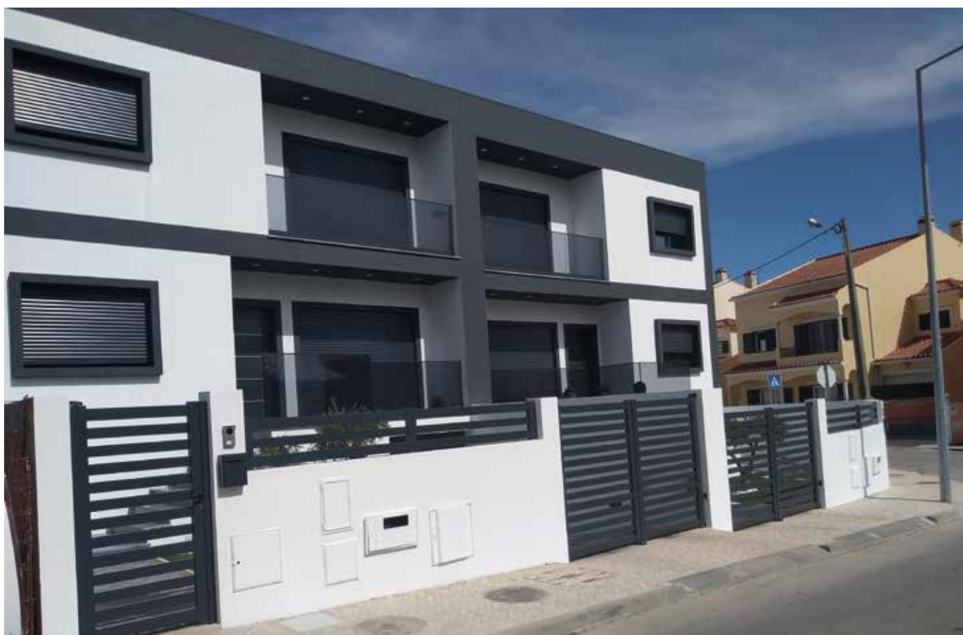
↑ Obra: Moradias Familiares // Localidade: Alenquer // Produtos: Fachada: Sistema ThermlInnov, Argamassa ThermlInnov 2009 Cinza, Argamassa ThermlInnov Areada Branco, Primário Pliomil Aquoso, Tinta Acrílica Pura 9G Branco e Cor | Interior: Primário Pliomil Aquoso, Superlavável Mate // Cliente: Paisagens Interiores // Comercial: Ricardo Alves
