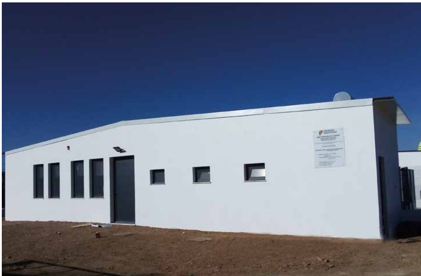
↑ Obra: Canil Municipal // Localidade: Alandroal // Produtos: Fachada: Primário Pliomil Aquoso, Isoplastic | Interior: Primário Pliomil Aquoso, Plas Seda | Portão: Primário Epoximar, Esmalte Forja // Cliente: Construções Alto de Santiago // Comercial: Vitor Neto
