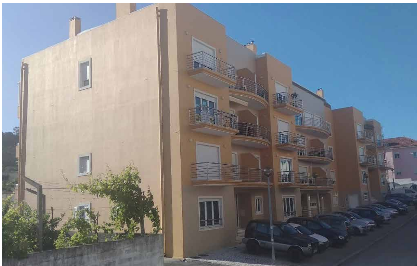
↑ Obra: Prédio Habitacional // Localidade: Malveira - Lisboa // Produtos: Fachada: Sistema ThermInnov, Tinta Acrílica Pura 9G // Cliente: Gabriel Pavanito Teles Comercial: António Franco
