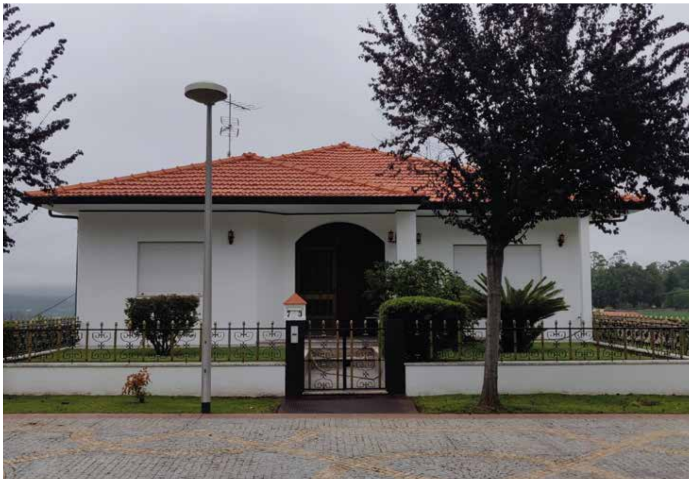
↑ Obra: Moradia Familiar // Localidade: Outiz - Vila Nova de Famalicão // Produtos: Telhados: Hidrofugante | Fachada: Primário Lamurite PL, Tinta Acrílica Pura 9G Muro: Lináqua | Gradeamento: Esmalte Policril Metalizado Ouro Novo // Cliente: Costa & Moita, Lda. // Comercial: Henrique Costa
