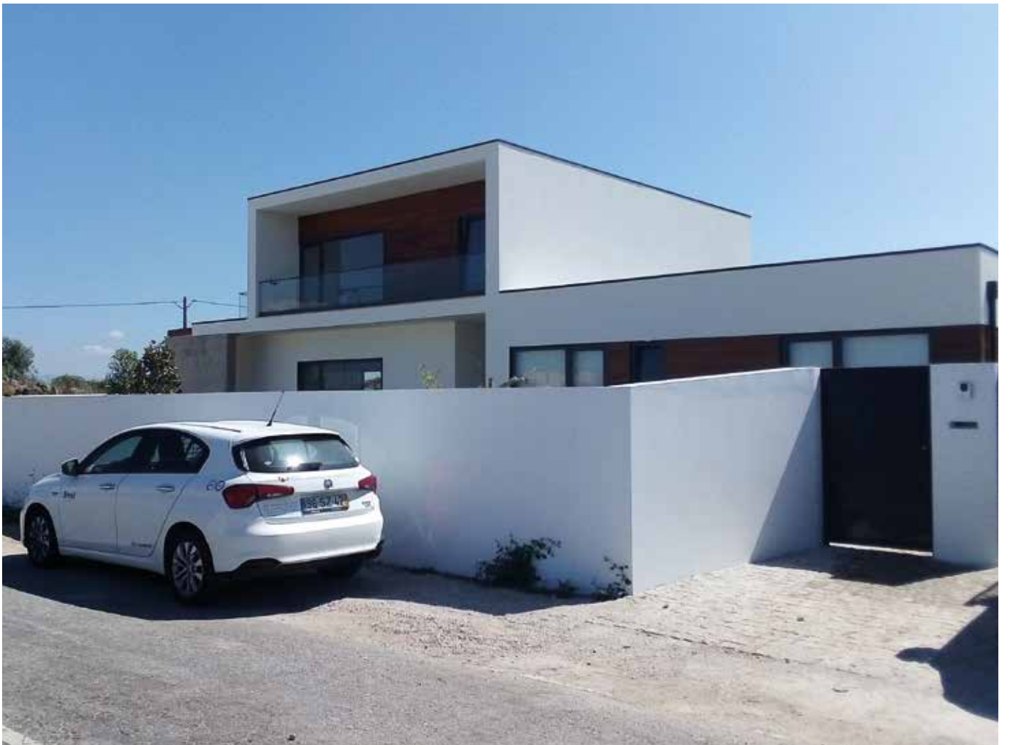
↑ Obra: Moradia Familiar // Localidade: Carregal do Sal // Produtos: Fachada: Primário Pliolite, Tinta Acrílica | Madeira: Verniz Probex Aquoso | Muro e Anexos: Tinta Acrílica AD Microtex // Cliente: Cosmohouse - Construção e Engenharia // Comercial: Luís Santos
