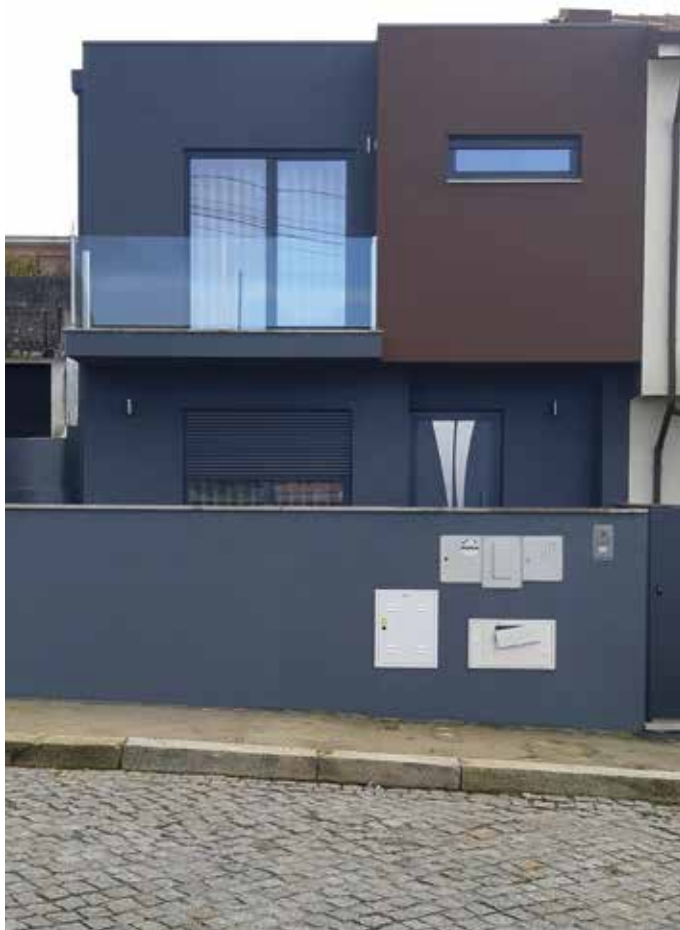
↑ Obra: Moradia Familiar // Localidade: Gondomar // Produtos: Fachada: Sistema ThermInnov // Cliente: António Campos Construções // Comercial: Hugo Mendes
