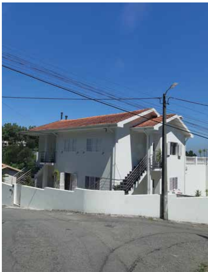
↑ Obra: Moradia Familiar // Localidade: Vila Nova de Gaia // Produtos: Fachada: Sistema ThermInnov // Cliente: António Campos Construções // Comercial: Hugo Mendes
