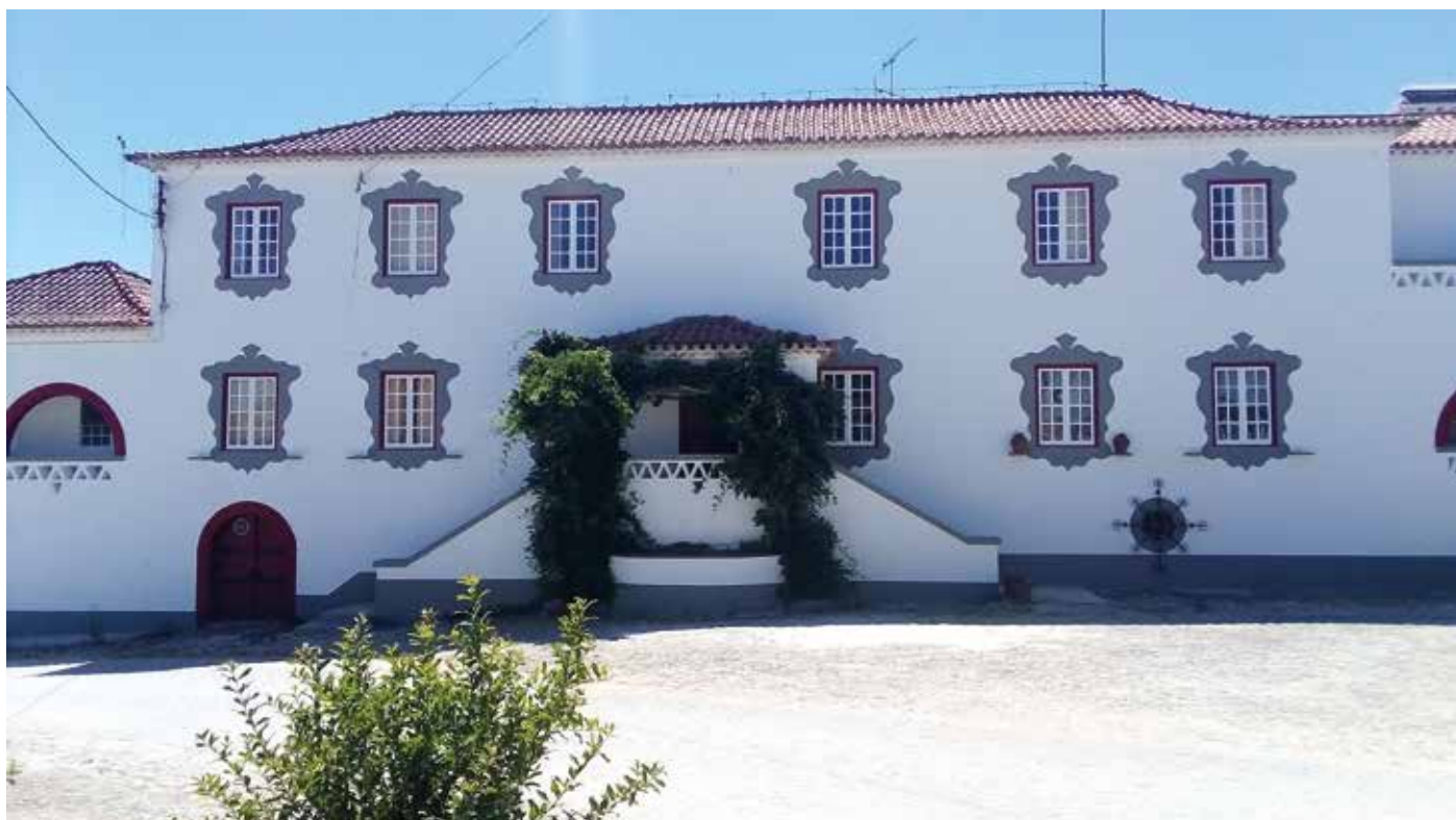
↑ Obra: Moradia Habitacional // Localidade: Alcácer do Sal // Produtos: Fachada: Primário Pliomil Aquoso, Plastec // Cliente: Luís Duarte // Comercial: Vítor Neto
