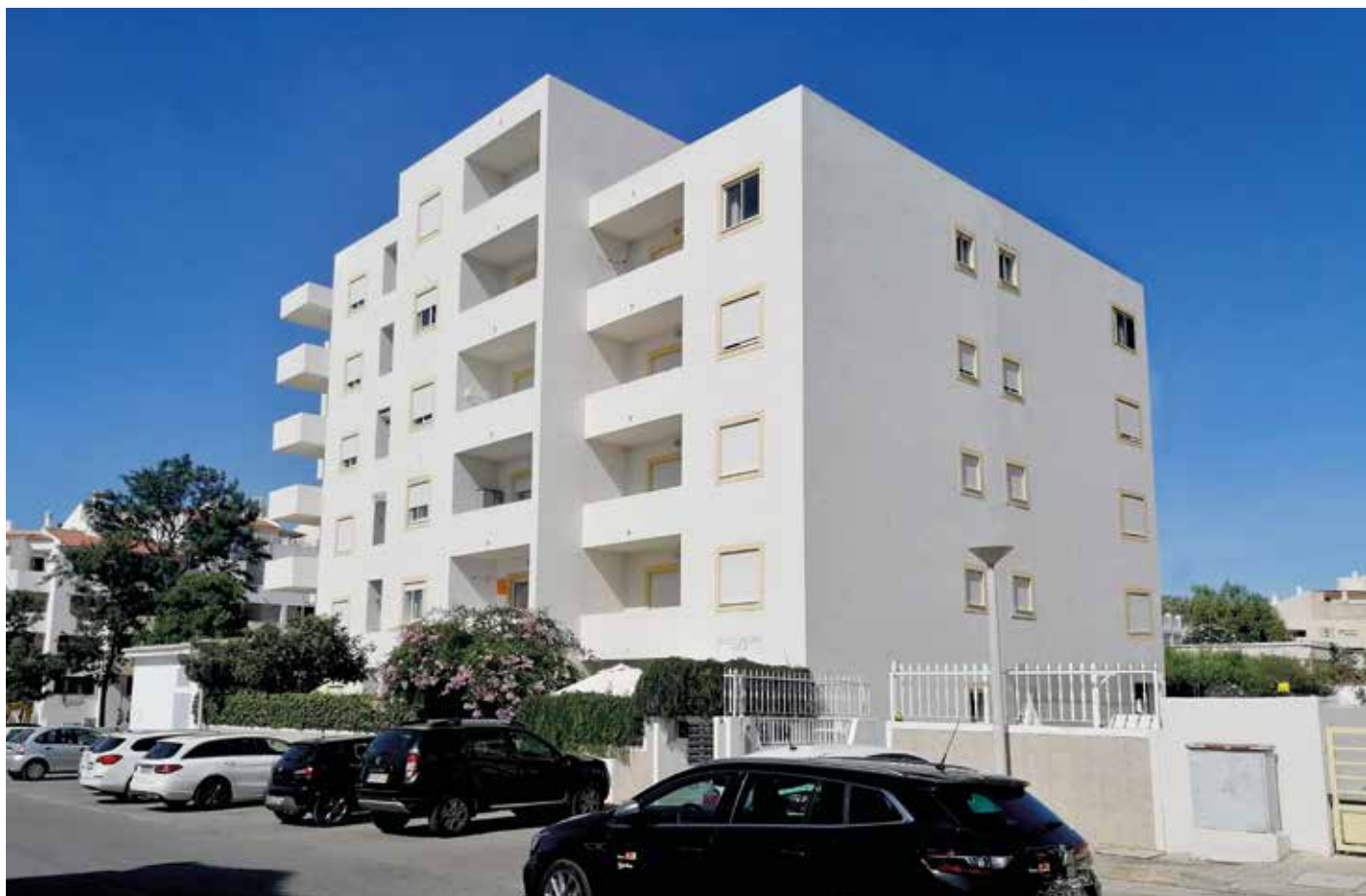
↑ Obra: Prédio Habitacional // Localidade: Albufeira // Produtos: Fachada: Isolante Betonilha, Argamassa Thermlnnov 2009, Tinta Acrílica Pura 9G // Cliente: Rogério Silva // Comercial: Fábio Rodrigues
