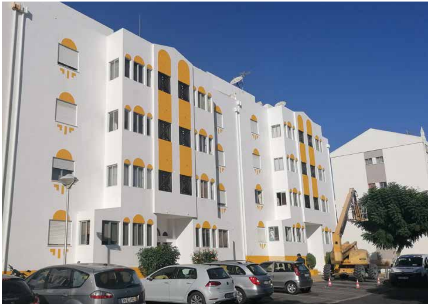
↑ Obra: Prédio Habitacional // Localidade: Tavira // Produtos: Fachada: Primário Pliomil Aquoso, Plas Super // Cliente: Leonardo Gonçalves // Comercial: João Vieira
