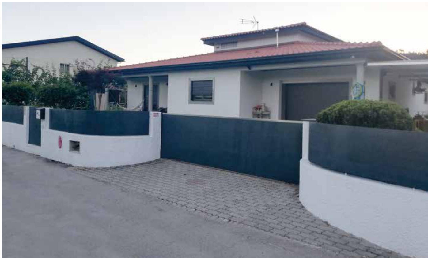
↑ Obra: Moradia Familiar // Localidade: Donim - Taipas // Produtos: Fachada: Isolante Betonilha, Argamassa ThermInnov 2009, Primário Pliomil Aquoso, Crepimil Extra R12 Branco e RAL 7016 | Muros: Plas Super Branco | Gradeamento e Portão: Esmalte PU MB RAL 7016 | Interior: Primário Pliomil Aquoso, Plastec Branco, Superlavável Mate Branco // Cliente: Régua Firme // Comercial: Daniel Gonçalves
