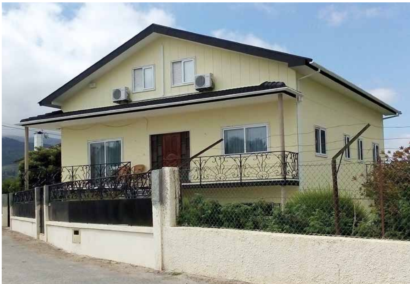
↑ Obra: Moradia Familiar // Localidade: Santa Marinha - Seia // Produtos: Telhado: Tinta Telhas Acetinada Preto | Fachada e Abas: Primário Lamurite PL, Tinta Acrílica Pura 9G Branco e TD 1322 Tropical | Gradeamento: Ferrolina Preto // Cliente: J. Maltez Saraiva & Figueiredo, Lda. // Comercial: António Sousa
