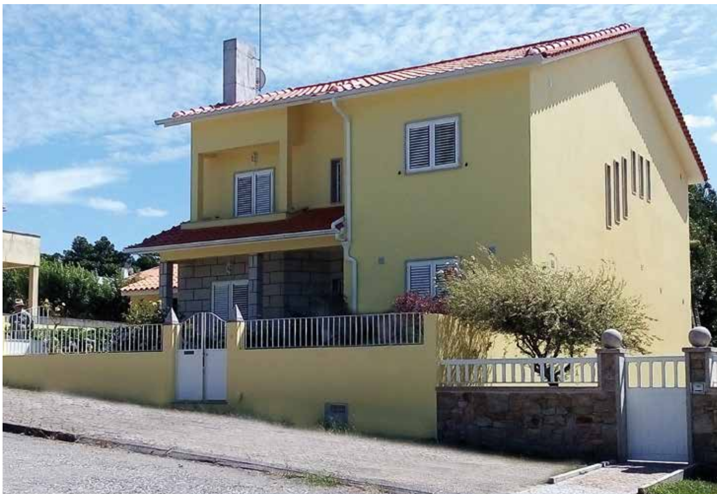
↑ Obra: Moradia Familiar // Localidade: Trancoso // Produtos: Telhado: Limpalina, Hidrofugante | Fachada e Abas: Primário Lamurite PL, Lináqua Branco e TD 1320 Aveia Cliente: Construções Manuel Filhos & Cª. Lda. // Comercial: António Sousa
