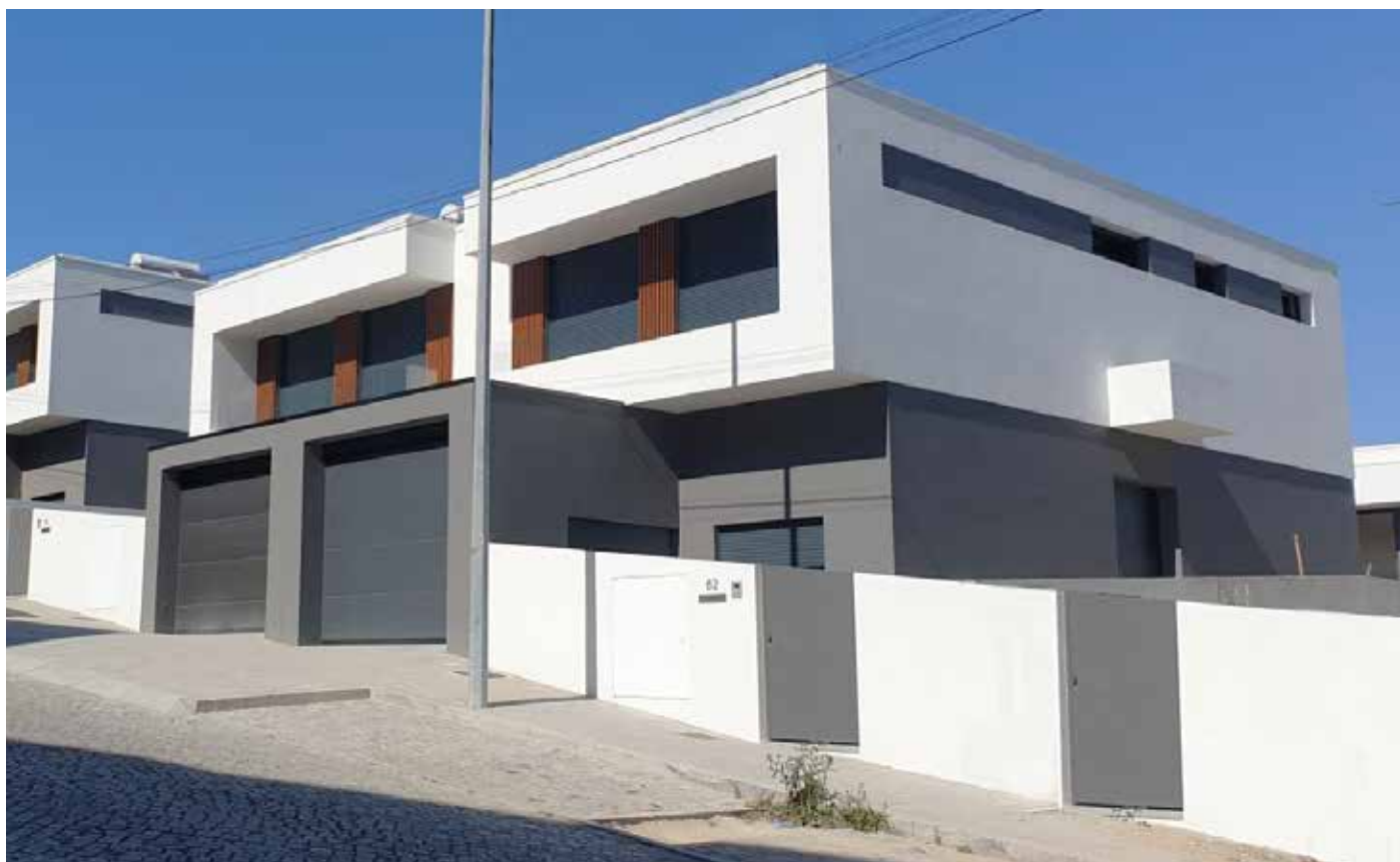
↑ Obra: Moradia Familiar // Localidade: Gondomar // Produtos: Fachada: Primário Lamurite Aquoso, Tinta Acrílica Pura 9G | Interior: Primário Lamurite Aquoso, Linamate // Cliente: Cardoso & Costa Construções // Comercial: Nuno Martins
