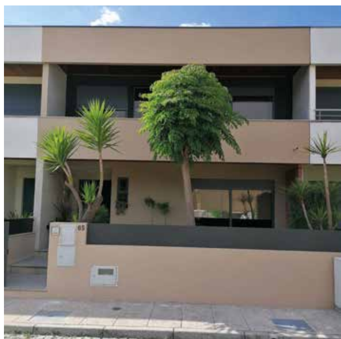
↑ Obra: Moradia Familiar // Localidade: Amares - Braga // Produtos: Fachada: Primário Pliomil, Tinta Acrílica AD | Gradeamento: Esmalte Forja Preto // Cliente: Lado Brilhante // Comercial: João Teixeira
