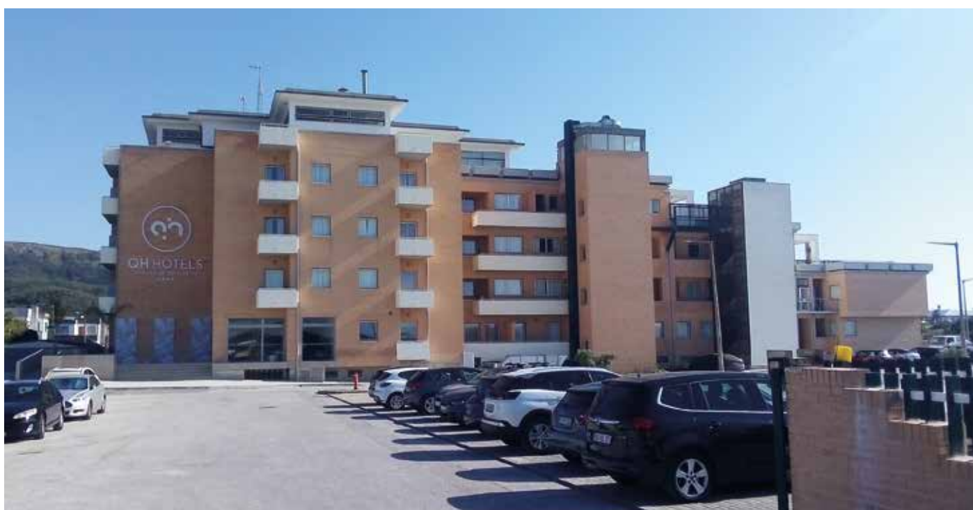
↑ Obra: Quiaios Hotel // Localidade: Quiaiaos - Figueira da Foz // Produtos: Fachada: Primário Pliomil, Tinta Acrílica Pura 9G | Pilares de Betão: Betomil
