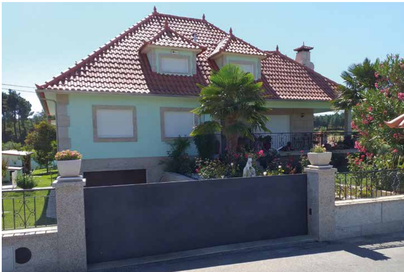
↑ Obra: Moradia Familiar // Localidade: Lagoas - Valpaços // Produtos: Granito: Hidrofugante | Telhado: Limpamil, Hidrofugante Aquoso Telhas | Fachada: Sistema ThermInnov, Crepimil Extra, Tinta Acrílica Pura 9G TD 088 Verde Água // Cliente: Sérgio Saraiva // Comercial: Marco Cardoso
