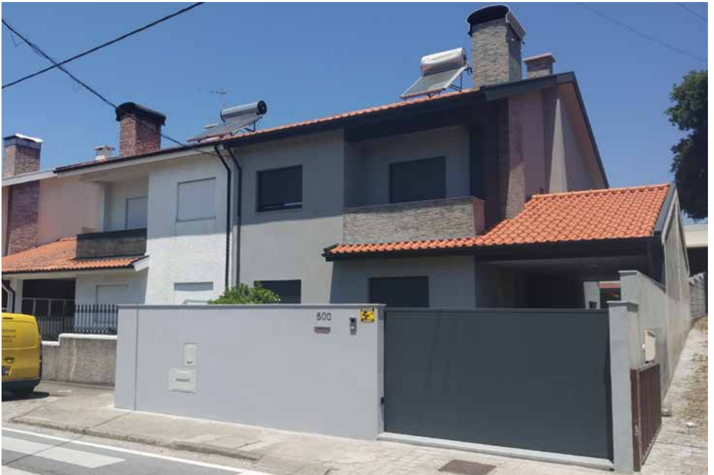
↑ Obra: Moradia Familiar // Localidade: Gondomar // Produtos: Fachada: Primário Isolina, Crepimil Extra, Niloplaste | Portão: Esmalte Nilaite // Cliente: José Luís Martins // Comercial: Nuno Martins
