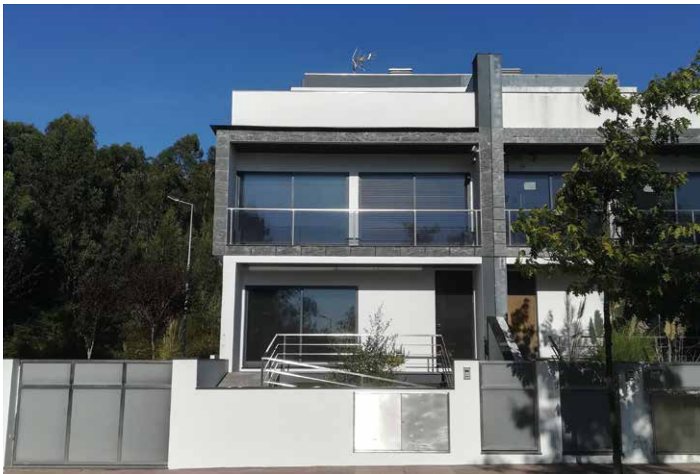
↑ Obra: Moradia Familiar // Localidade: Maia // Produtos: Fachada: Argamassa ThermInnov, Isolante Betonilha, Crepimil Extra, Primário Isoselante, Tinta Acrílica Pura 9G Branco // Cliente: Joaquim Santos Leite // Comercial: Miguel Amaral
