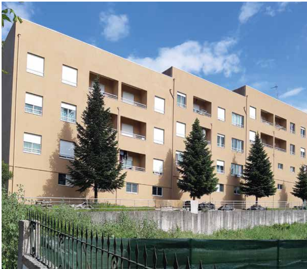
↑ Obra: Prédio Habitacional // Localidade: Penafiel // Produtos: Fachada: Sistema ThermInnov // Cliente: Well Done // Comercial: Hugo Mendes
