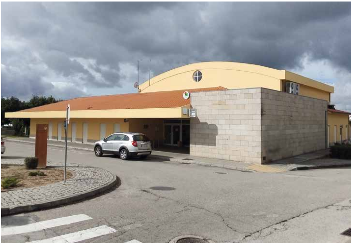
↑ Obra: Central de Camionagem // Localidade: Celourico da Beira // Produtos: Fachada: Linatex TD 1329 Duna // Cliente: Maximiano & Pires, Lda. // Comercial: António Sousa
