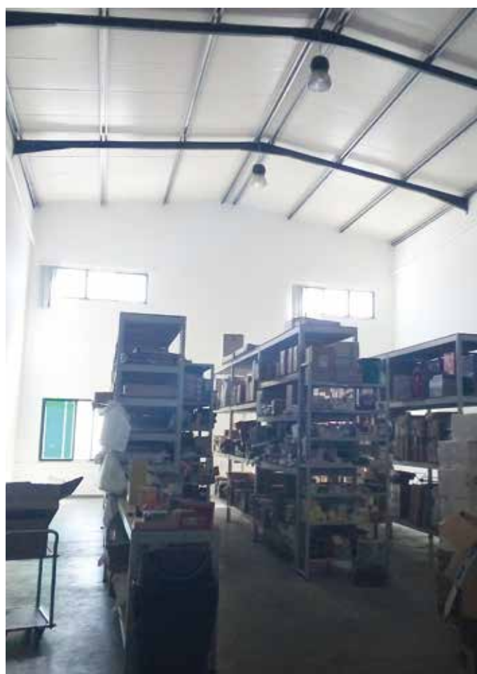
↑ Obra: Interior de Armazém // Localidade: Borba // Produtos: Interior: Solução Anti-fungos, Primário Ecopliomil, Plastec // Cliente: António Franco // Comercial: Vitor Neto
