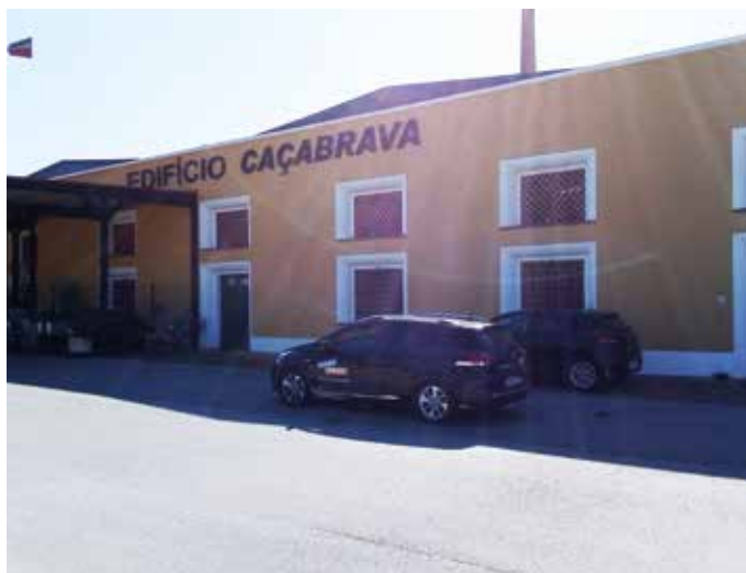
↑ Obra: Edifício Caçabrava // Localidade: Santa Cita - Tomar // Produtos: Fachada: Linatex, Lináqua // Cliente: Marco Costa // Comercial: José Conde
