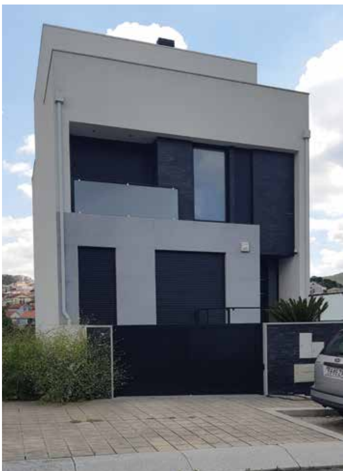
↑ Obra: Moradia Familiar // Localidade: Rio Tinto // Produtos: Fachada: Sistema ThermInnov // Cliente: António Campos Construções // Comercial: Hugo Mendes
