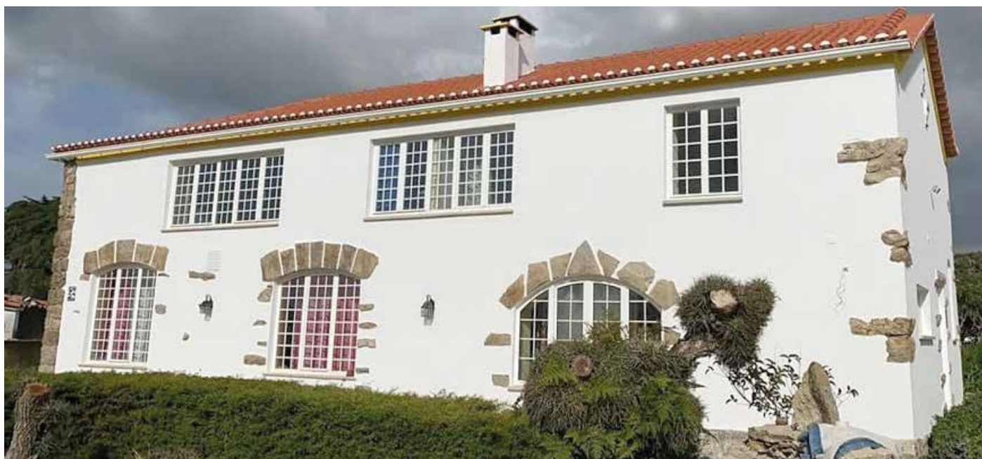
↑ Obra: Moradia Familiar // Localidade: Sintra // Produtos: Fachada: Primário Lamurite Aquoso, Tinta Acrílica Pura 9G Branco e Cor // Cliente: Planeta Salteado Comercial: Luís Alves
