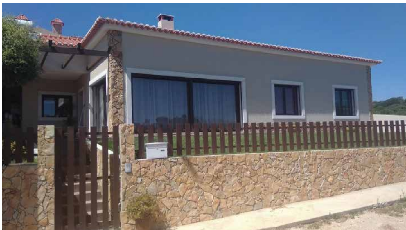
↑ Obra: Moradia Familiar // Localidade: Mafra - Lisboa // Produtos: Fachada: Sistema ThermInnov, Tinta Acrílica Pura 9G // Cliente: NCS Cores, Lda. // Comercial: António Franco
