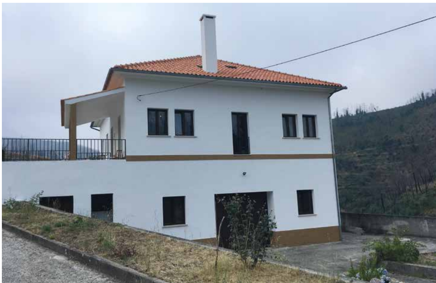
↑ Obra: Moradia Familiar // Localidade: Pampilhosa da Serra // Produtos: Telhado: Limpamil, Hidrofugante | Fachada: Primário Pliomil Branco, Tinta Acrílica Pura 9G Cliente: Gonçalo Barateiro Diogo // Comercial: Armando Almeida
