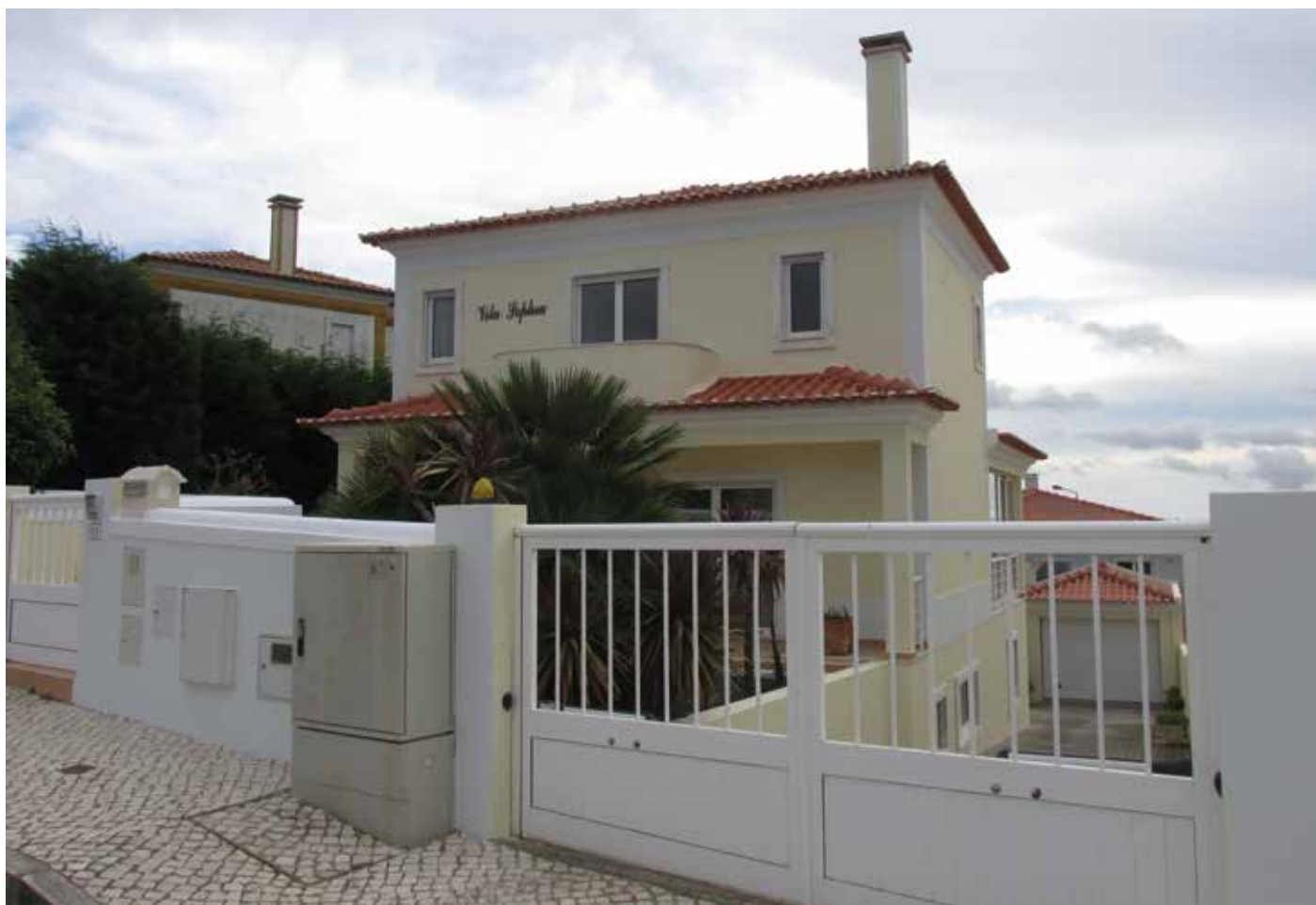
↑ Obra: Moradia Familiar // Localidade: Óbidos // Produtos: Fachada: Primário Pliomil, Tinta Acrílica Pura 9G // Cliente: Floriano Pereira // Comercial: Ricardo Alves
