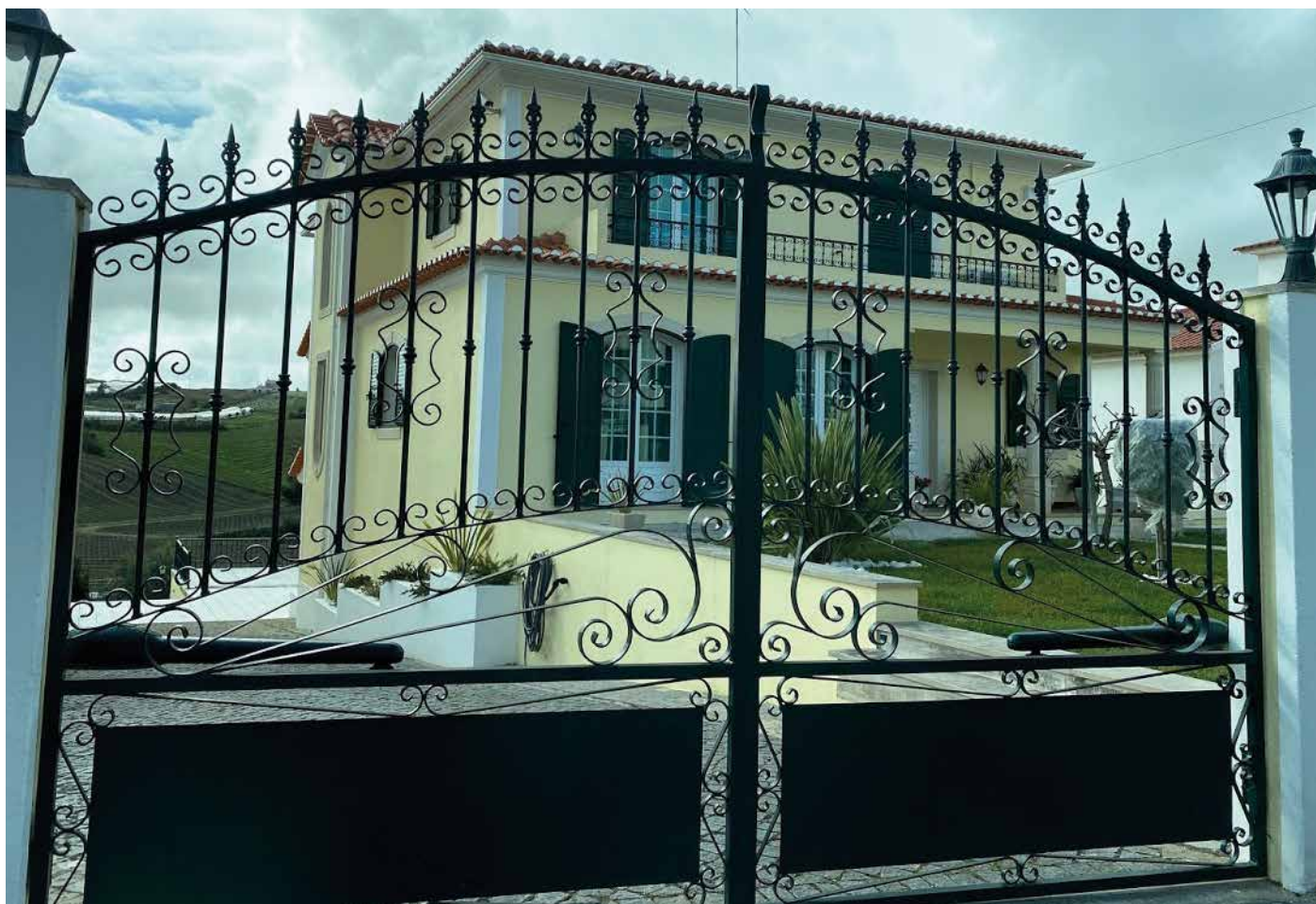
↑ Obra: Moradia Familiar // Localidade: Fernandinho - Torres Vedras // Produtos: Fachada: Primário Lamurite Aquoso, Tinta Texturada CC, Tinta Acrílica Pura 9G Branco e Cor | Gradeamento: Ferrolina Preto // Cliente: Freiripinta // Comercial: Luís Alves
