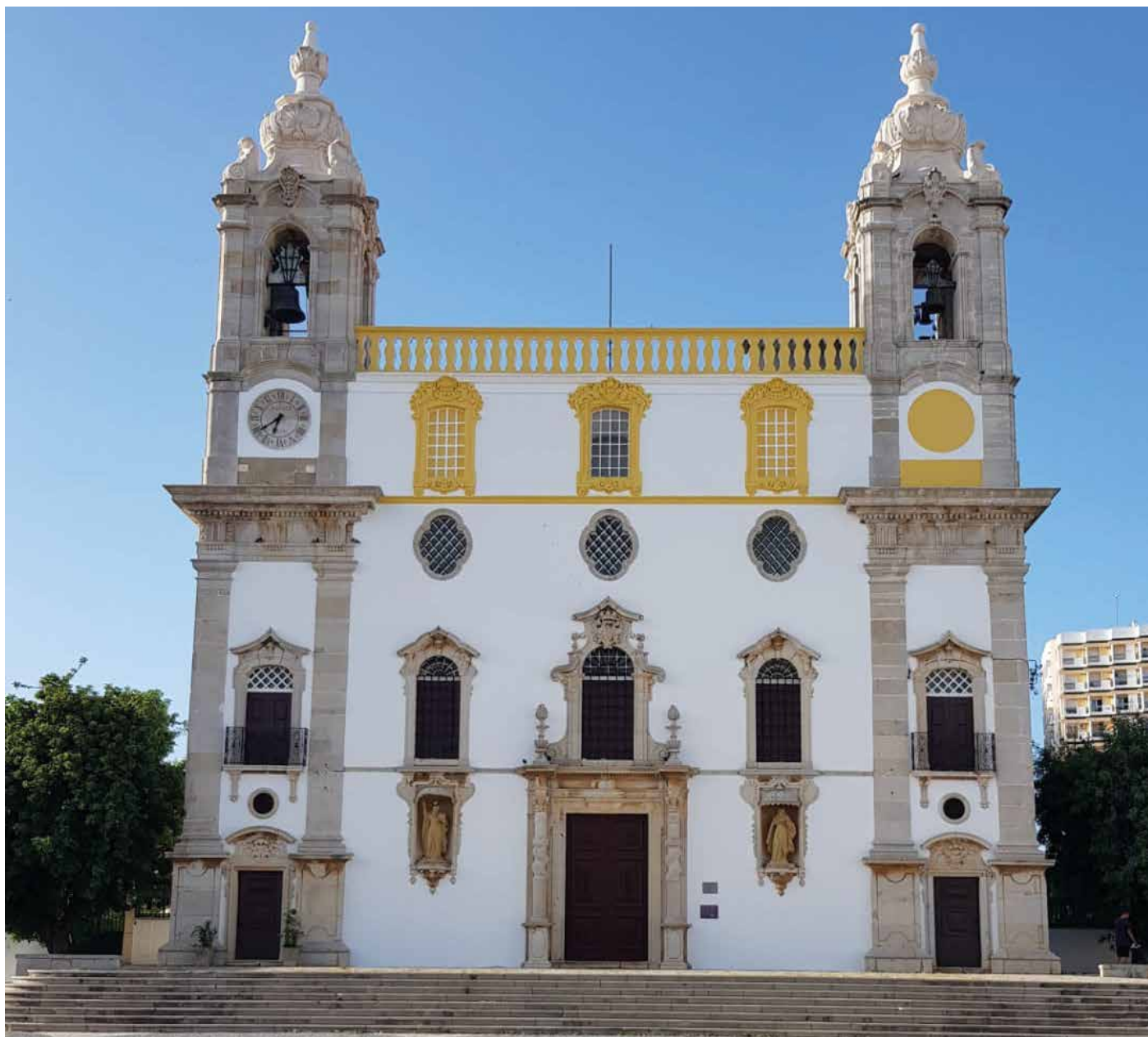
↑ Obra: Igreja do Carmo // Localidade: Faro // Produtos: Revestimento à base de Silicato // Cliente: Bloco de Ouro, Lda. // Comercial: Claudio Lourenço
