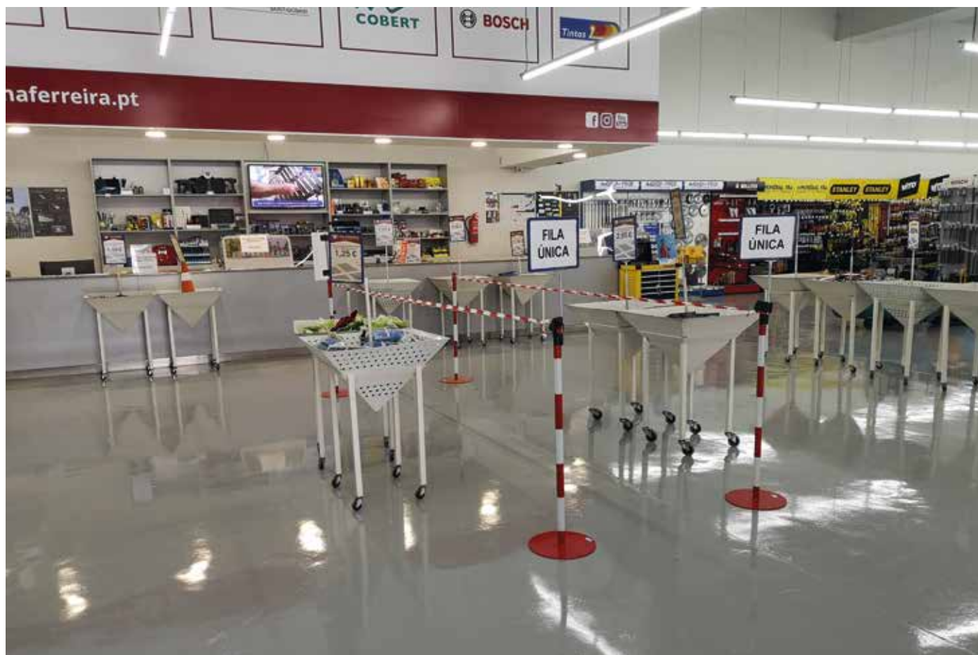
↑ Obra: Pavimento do Espaço Comercial Pina Ferreira // Localidade: Vila Nova de Famalicão // Produtos: Tinta Pavimentos PU NCS S 4000-N // Cliente: Pina Ferreira Comercial: Rui Ramos
