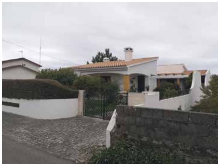
↑ Obra: Moradia Familiar // Localidade: Tarelhos - Cantanhede // Produtos: Fachada: Primário Pliomil, Tinta Acrílica Pura 9G | Gradeamentos: Esmalte HB Gal | Madeiras: Verniz Probex Aquoso Mogno // Cliente: Rui Baião // Comercial: Mário Melo
