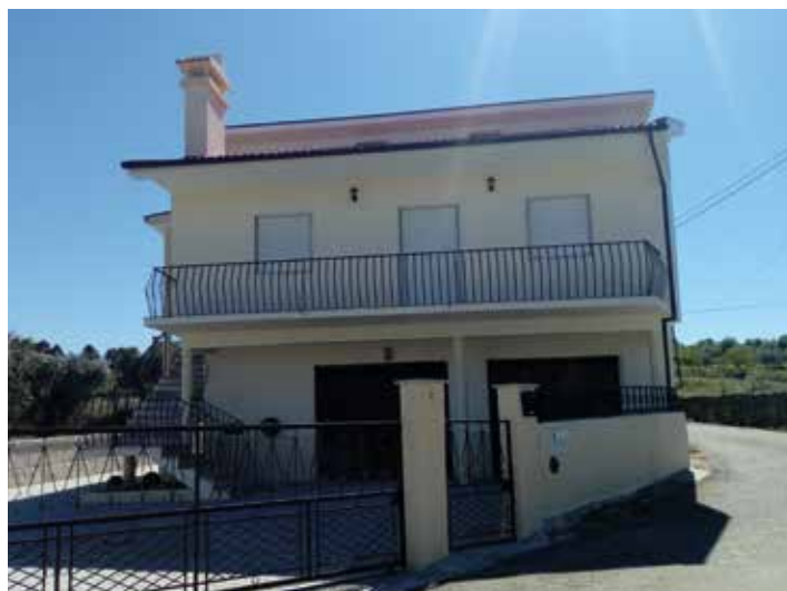
↑ Obra: Moradia Familiar // Localidade: Ribamondego - Gouveia // Produtos: Telhados: Tinta para Telhas na cor Tijolo Fachadas: Primário Lamurite PL, Tinta Acrílica Pura 9G // Ciente: Fernando Andrade Ribeiro // Comercial: Luís Almeida
