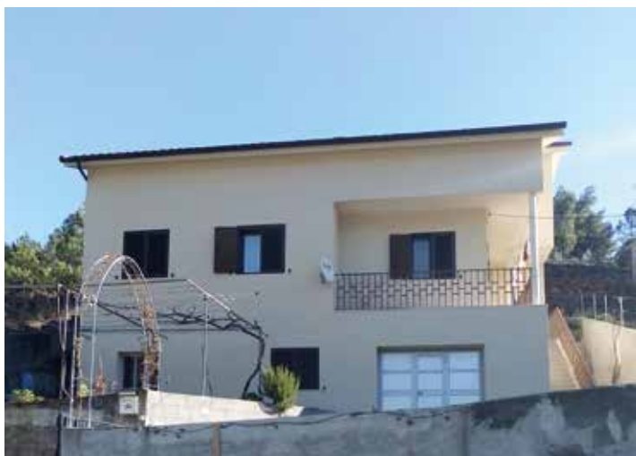
↑ Obra: Moradia Familiar // Localidade: Sobral de São Miguel - Covilhã // Produtos: Argamassa Thermlnno 2009 Cinza, Primário Isolina NCS S1010-Y20R, Crepimil Extra T15 NCS S1010-Y20R // Cliente: António Brás Vicente // Comercial: António Sousa
