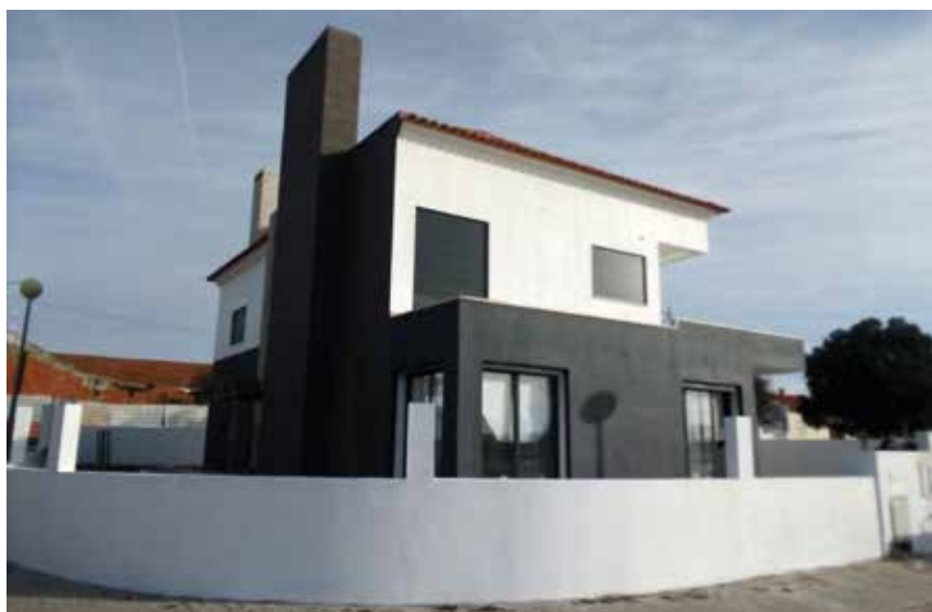
↑ Obra: Moradia Familiar // Localidade: Grândola // Produtos: Primário Pliomil Aquoso e Tinta Acrílica Pura 9G // Cliente: Luís Duarte // Comercial: Vitor Neto
