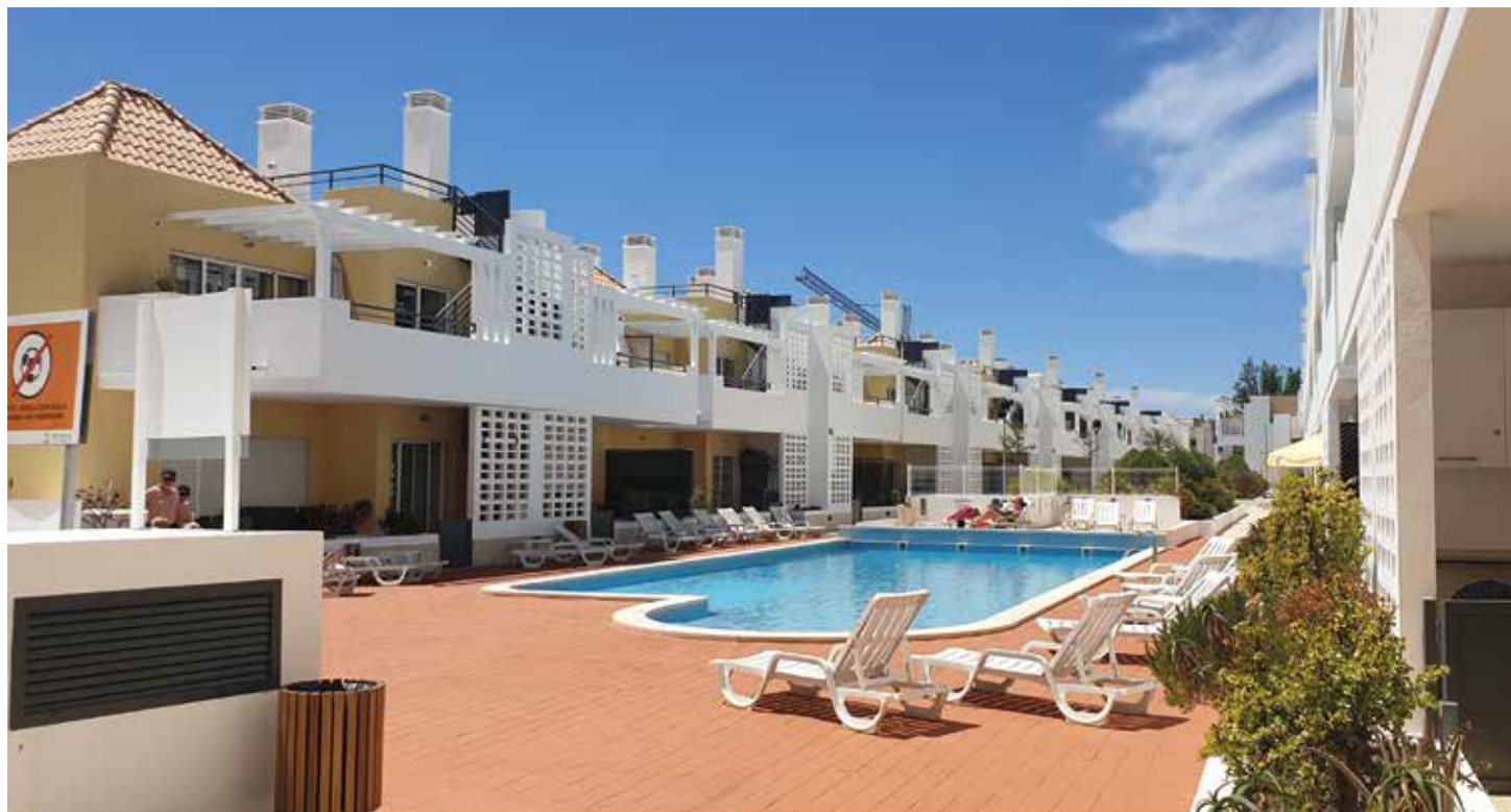
↑ Obra: Moradias Familiares // Localidade: Cabanas de Tavira // Produtos: Exterior: Primário Pliomil Aquoso, Plas Super | Gradeamentos: Esmalte Ferromil // Cliente: Paulo Ricardo Pinto // Comercial: João Vieira
