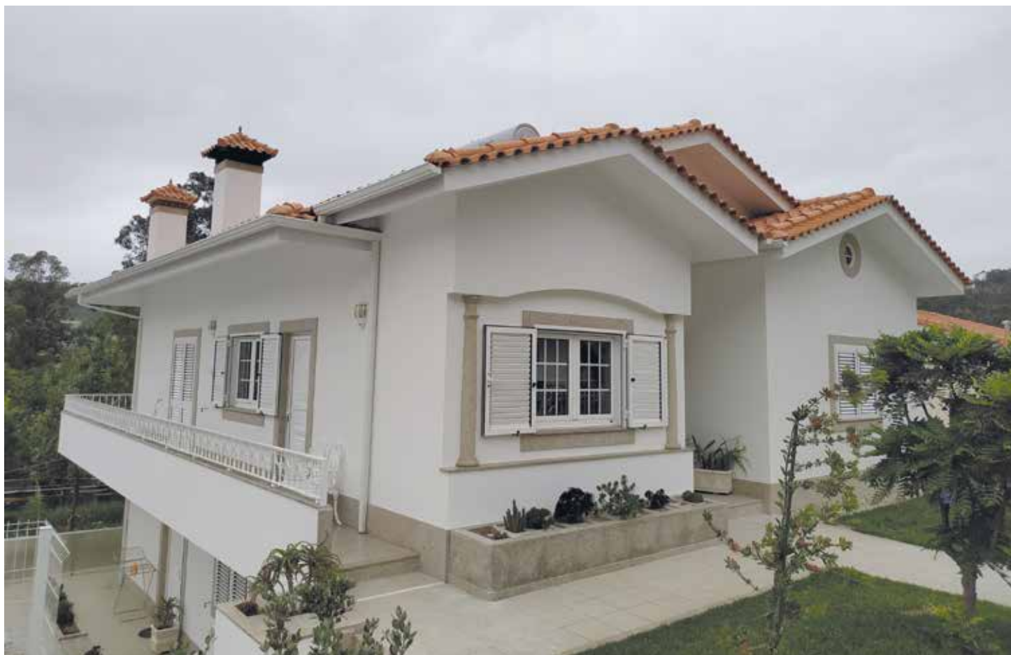
↑ Obra: Moradia Familiar // Localidade: Vermil - Guimarães // Produtos: Fachada: Argamassa Thermlnnov 2009, Primário Isolina, Crepimil Extra R8 Branco, Tinta Acrílica Pura 9G Branco | Gradeamentos: Esmalte Nilaite Branco // Ciente: Ribeiro da Silva & Cª, Lda. // Comercial: Carlos Oliveira
