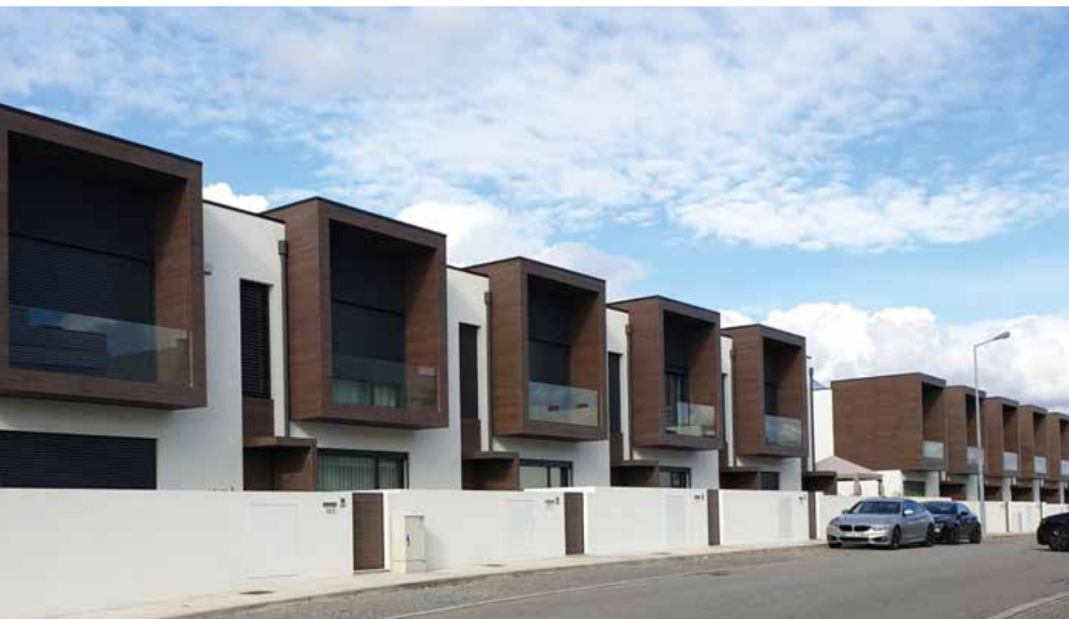
// Localidade: Gondomar // Produtos: Fachada: Primário Lamurite PL , Tinta Acrílica Pura 9G | Interior: Primário Lamurite PL, Cardoso & Costa, Lda. // Comercial: Nuno Martins
