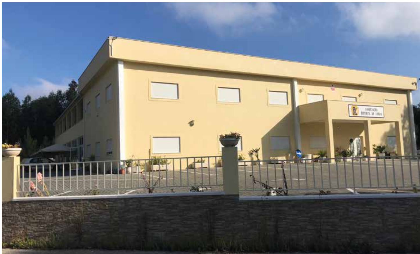
↑ Obra: Associação Espírita de Leiria // Localidade: Leiria // Produtos: Primário Pliomil Aquoso, Plas Super // Cliente: José de Oliveira Azevedo // Aplicador: Armando Rodrigues Vieira // Comercial: Joaquim Basto
