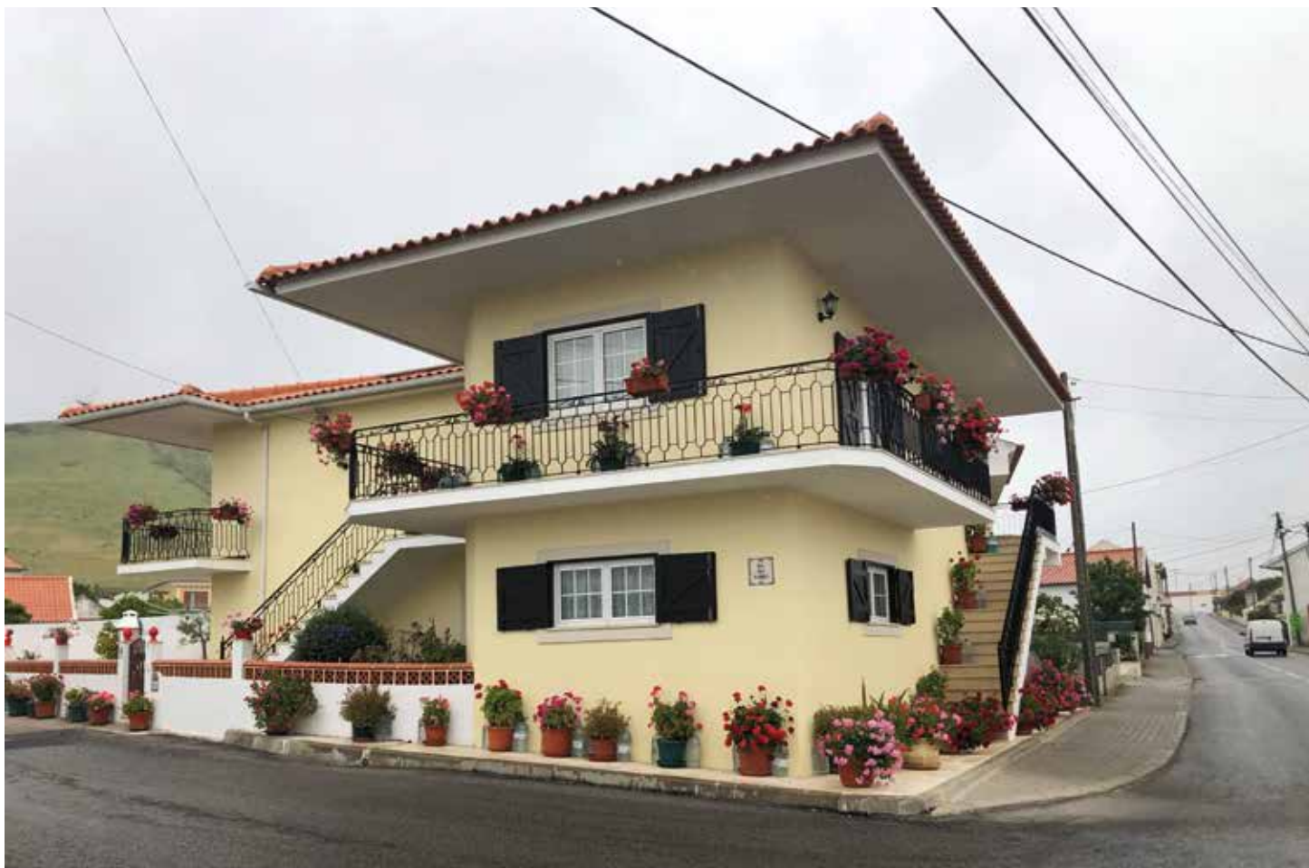
↑ Obra: Moradia Familiar // Localidade: Freiria - Torres Vedras // Produtos: Limpalina, Hidrofugante Aquoso Telhas, Primário Lamurite Aquoso, Tinta Acrílica Pura 9G // Cliente: Freiripinta, Lda. // Comercial: Luís Alves
