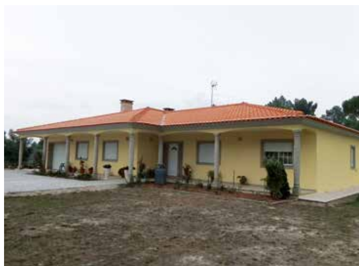
↑ Obra: Moradia Familiar // Localidade: Póvoa de Cervães // Produtos: Telhados: Limpalina, Hidrofugante Aquoso Telhas | Exterior: Primário Lamurite PL, Elastoflex Aveia, Lináqua TD 7045 // Cliente: Fernando Andrade Ribeiro // Comercial: Luís Almeida
