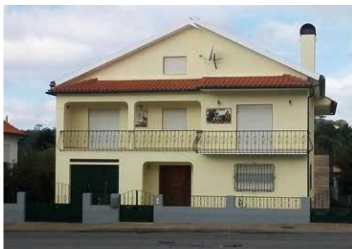
↑ Obra: Moradia Familiar // Localidade: Vagueira - Aveiro // Produtos: Primário Lamurite Aquoso, Tinta Acrílica Pura 9G Tropical, Lináqua TD 7045 // Cliente: António Almeida Andrade // Comercial: Luís Almeida
