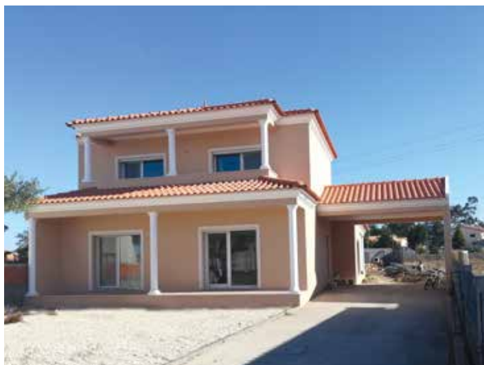
↑ Obra: Moradia Familiar // Localidade: Ermida - Mira // Produtos: Telhados: Limpamil, Hidrofugante Aquoso Telhas | Fachada: Primário Pliomil, Tinta Acrílica Pura 9G // Cliente: Rui Baião // Comercial: Mário Melo
