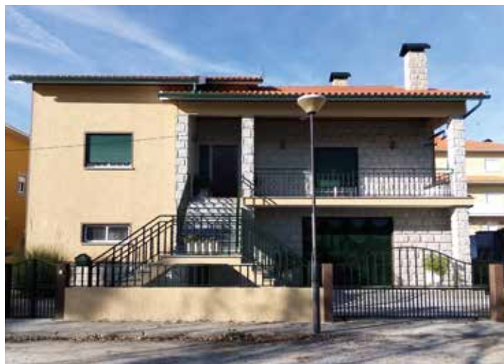
↑ Obra: Moradia Familiar // Localidade: Santa Comba - Seia // Produtos: Primário Lamurite PL, Tinta Acrílica Pura 9G Branco, TD 8579 e TD 521 | Grades: Ferrolina RAL 6009 // Cliente: J. Maltez Saraiva & Figueiredo Construção Civil, Lda. // Comercial: António Sousa
