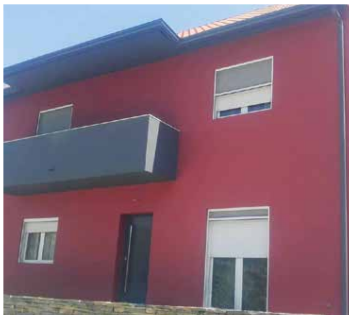
↑ Obra: Moradia Familiar // Localidade: Sintra // Produtos: Sistema ThermInnov, Primário Isolina, Tinta Acrílica Pura 9G // Ciente: J. Pinturas, Lda. // Comercial: Luís Alves
