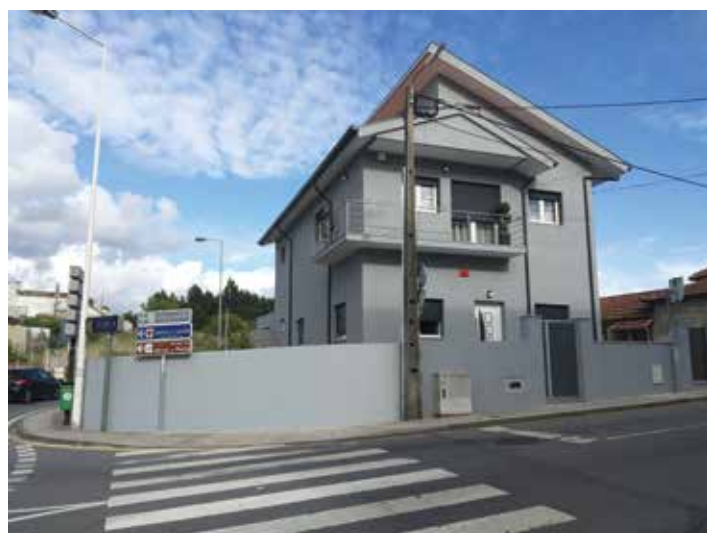
↑ Obra: Moradia Familiar // Localidade: Gondomar // Produtos: Primário Isolina, Crepimil Extra // Cliente: Adriano Soares de Sousa // Comercial: Pedro Dias e Nuno Martins
