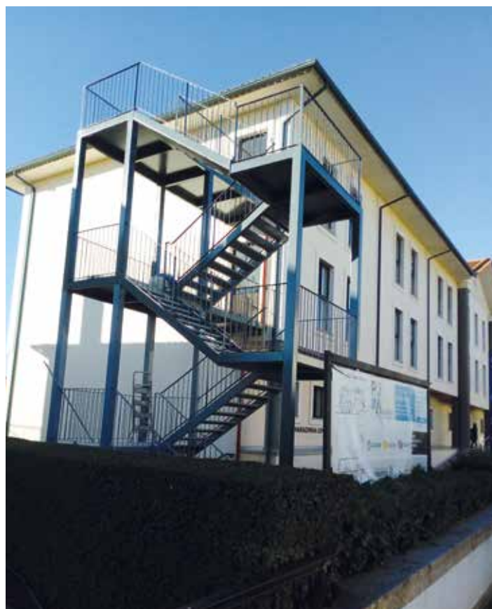
↑ Obra: Estrutura metálica para escadas da Santa Casa da Misericórdia // Localidade: Mangualde // Produtos: Primário Epoximar, Esmalte Sintético SR // Cliente: PJA Ferreira, Lda. // Comercial: Luís Almeida
