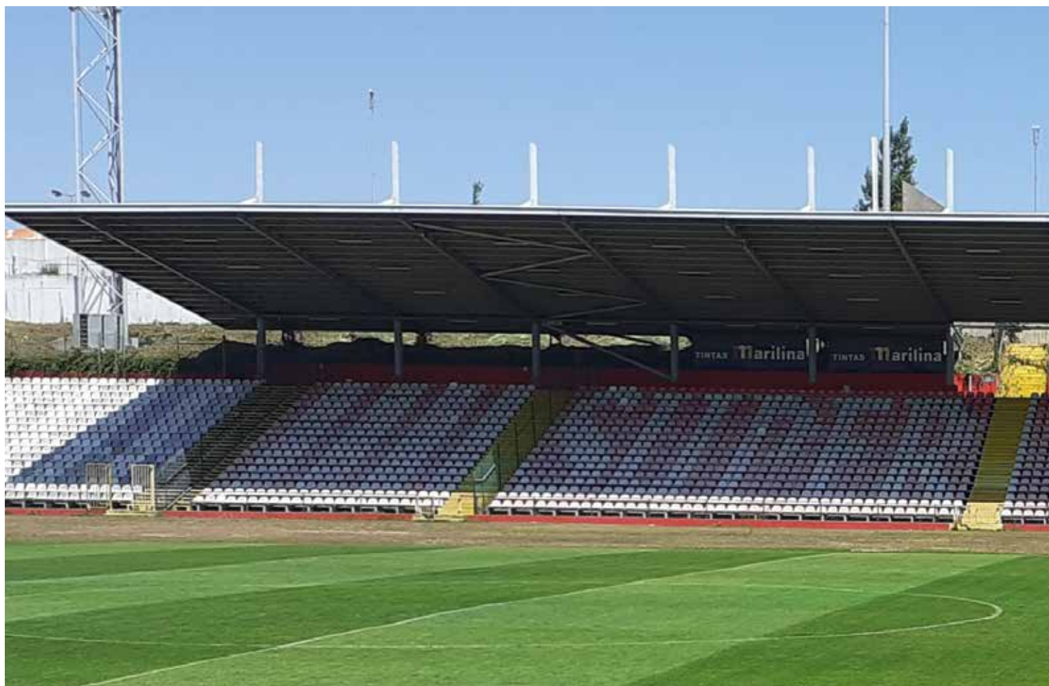
↑ Obra: Bancada do Estádio do Mar - Leixões Spot Clube // Localidade: Matosinhos // Produtos: Esmalte Policril Vermelho e Branco
