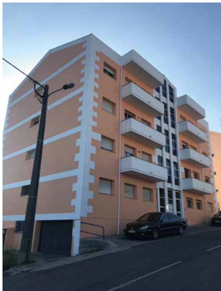
↑ Obra: Prédio Habitacional // Localidade: Leiria // Produtos: Primário Pliomil Aquoso, Plas Super // Cliente: José de Oliveira Azevedo // Comercial: Joaquim Basto
