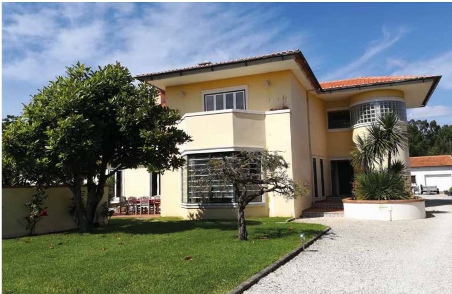
↑ Obra: Moradia Familiar // Localidade: Vilamar - Cantanhede // Produtos: Telhado: Limpamil, Hidrofugante Aquoso Telhas | Fachada: Primário Pliomil, Plas Super // Ciente: Colorfel // Comercial: Mário Melo
