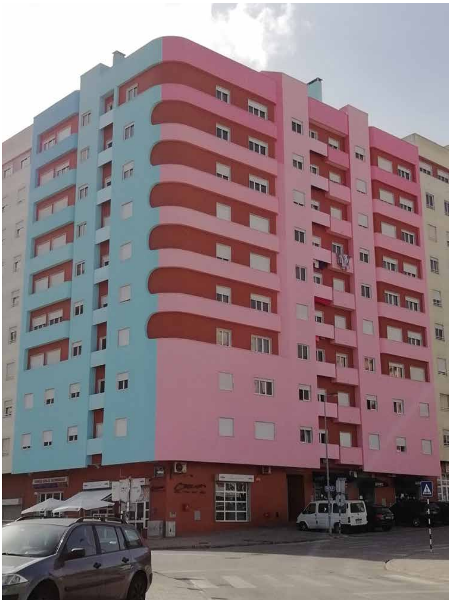
↑ Obra: Prédio Habitacional // Localidade: Corroios // Produtos: Primário Isolina, Tinta Acrílica AD // Ciente: Pinabra - Importação, Exportação e Construções, Unipessoal, Lda. // Comercial: Fernando Bento
