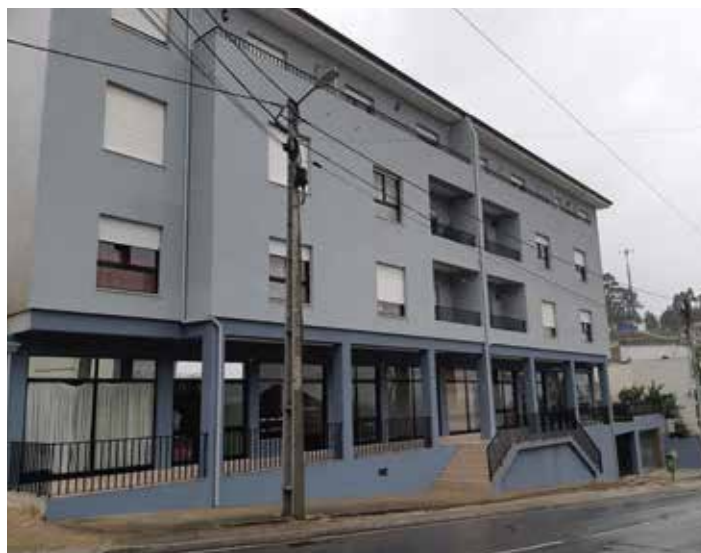
↑ Obra: Prédio Habitacional // Localidade: Freamunde // Produtos: Sistema Thermlnnov // Cliente: Well Done // Comercial: Hugo Mendes
