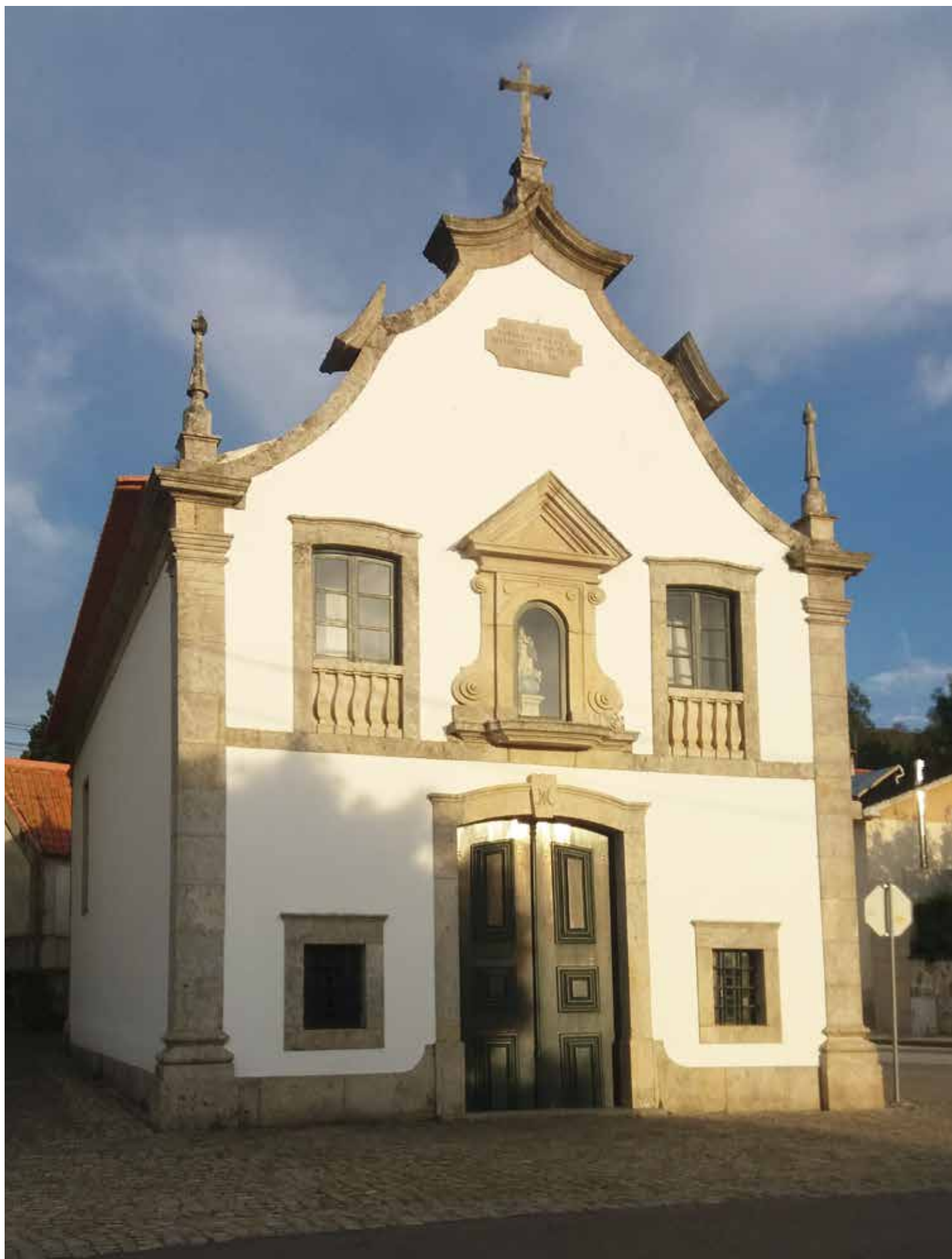
↑ Obra: Capela da Senhora da Conceição da Rocha // Localidade: Nogueira - Viana do Castelo // Produtos: Primário Pliomil Aquoso, Tinta Acrílica Pura 9G Branco // Ciente: STRUB
