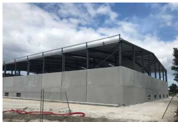
↑ Obra: Estrutura Metálica // Localidade: Marinha Grande // Produtos: Primário Epoxi Zinco 17421, Esmalte Acrílico Fosco // Aplicador: Carlos Cozinheiro, Lda. // Ciente: José de Oliveira Azevedo // Comercial: Joaquim Basto
