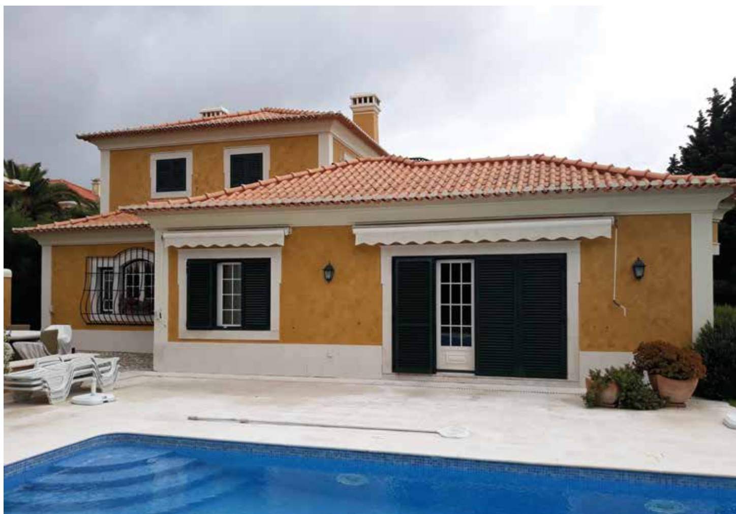
↑ Obra: Moradia Familiar // Localidade: Quinta da Beloura - Sintra // Produtos: Argamassa ThermInnov 2009, Isolante Betonilha, Primário Lamurite Aquoso, Tinta Acrílica Pura 9G Branco Pedra | Esponjado: Tinta Acrílica Pura 9G Ocre e Branco Pedra // Ciente: CP Silva // Comercial: Edgar Ribeiro
