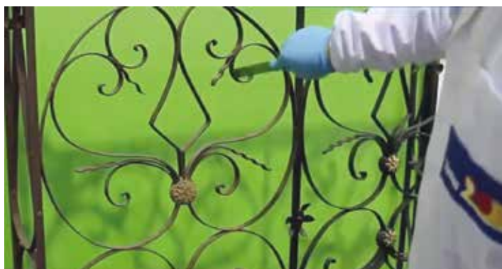
↑ Remoção de tinta velha e da ferrugem com espátula
