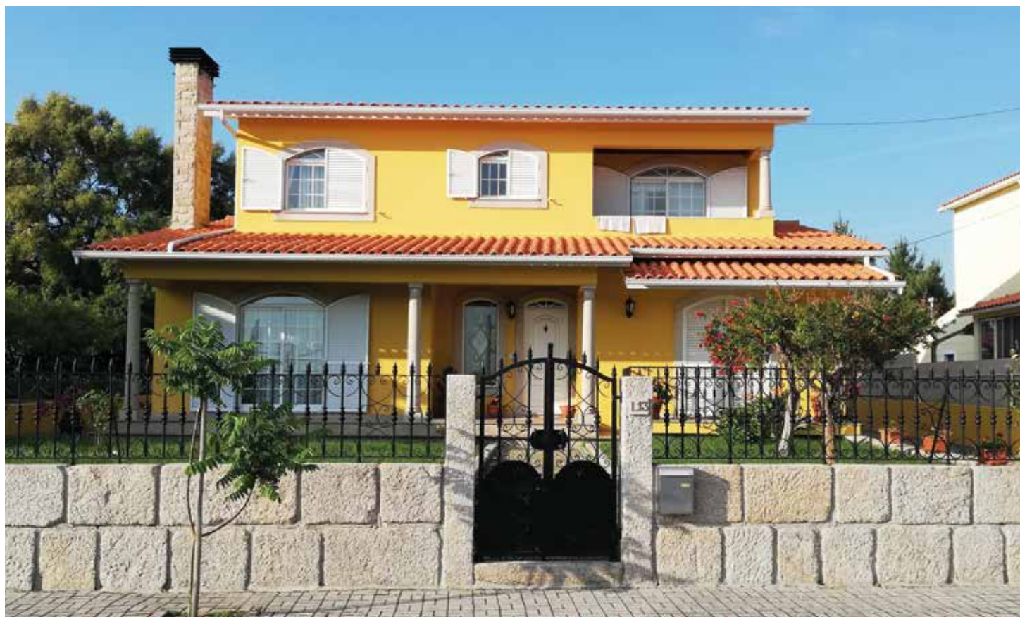
↑ Obra: Moradia Familiar // Localidade: Nelas // Produtos: Exterior: Primário Pliomil Branco, Tinta Acrílica Pura 9G Branco e TD 589 Mostarda | Interior: SuperLavável Mate Branco | Tetos Exteriores de Madeira: Probex Acetinado 294 Cerejeira | Gradeamentos: Esmalte Ferromil Preto // Ciente: Luis Bernardino // Comercial: Nuno Coimbra
