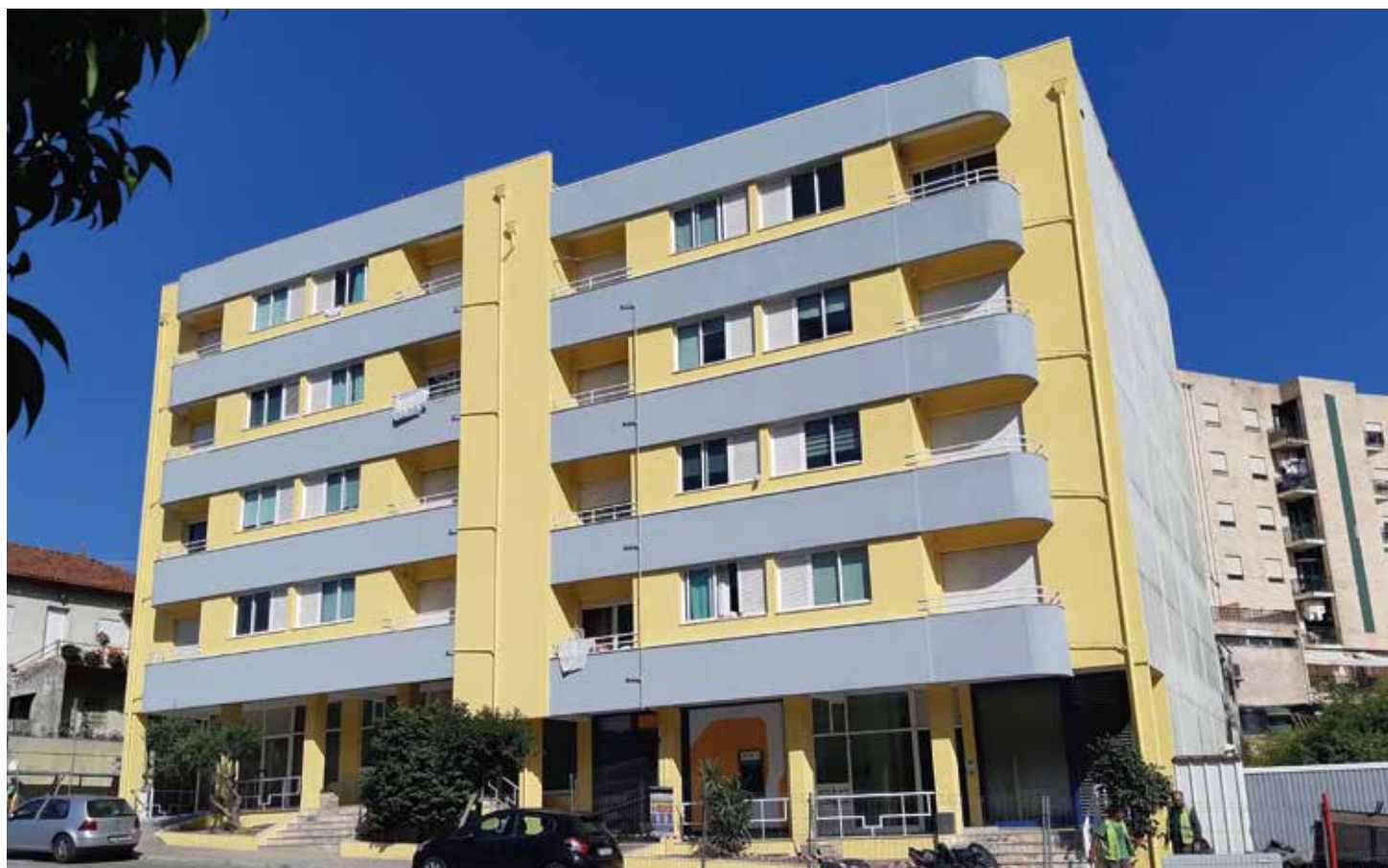
↑ Obra: Prédio Habitacional // Localidade: Rebordosa // Produtos: Sistema ThermInnov // Cliente: Well Done // Comercial: Hugo Mendes
