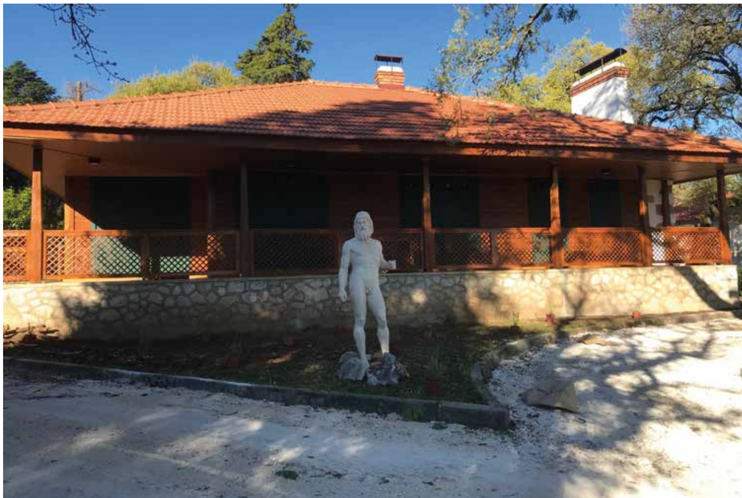
↑ Obra: Moradia Familiar // Localidade: Porto de Mós // Produtos: Primário Pliomil Aquoso, Plas Super // Cliente: José de Oliveira Azevedo // Aplicador: Pintamacieira, Lda. // Comercial: Joaquim Basto
