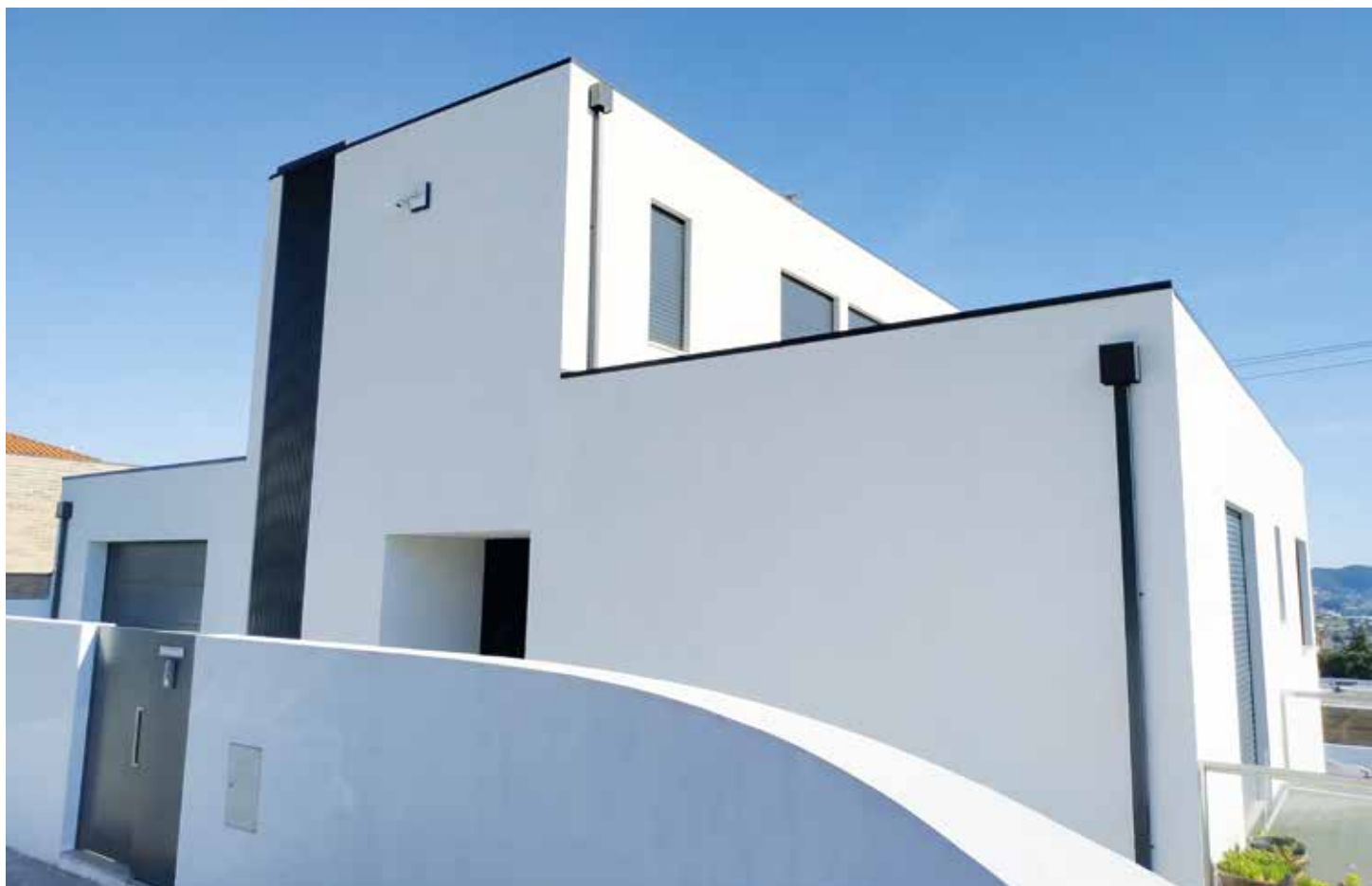
↑ Obra: Moradia Familiar // Localidade: Braga // Produtos: Fachada: Sistema ThermInnov com Crepimil Extra R10 Branco | Portões e Tubos de Queda: Esmalte Nilaite Ral 7016 // Cliente: Patrisólido - Construção Civil, Lda. // Comercial: Carlos Oliveira
