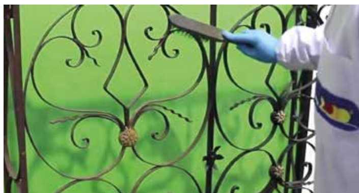
↑ Remoção de tinta velha e da ferrugem com escova de arame
