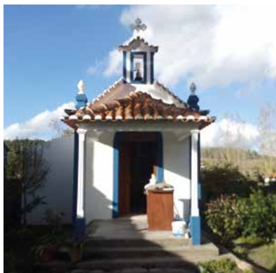
↑ Obra: Igreja de Santo André // Localidade: Santa Justa do Couço // Produtos: Exterior: Primário Pliomil Aquoso, Tinta Acrílica Pura 9G | Interior: Primário Pliomil Aquoso, Esmalte Milacril Mate // Cliente: Joaquim Pires // Comercial: Vitor Neto
