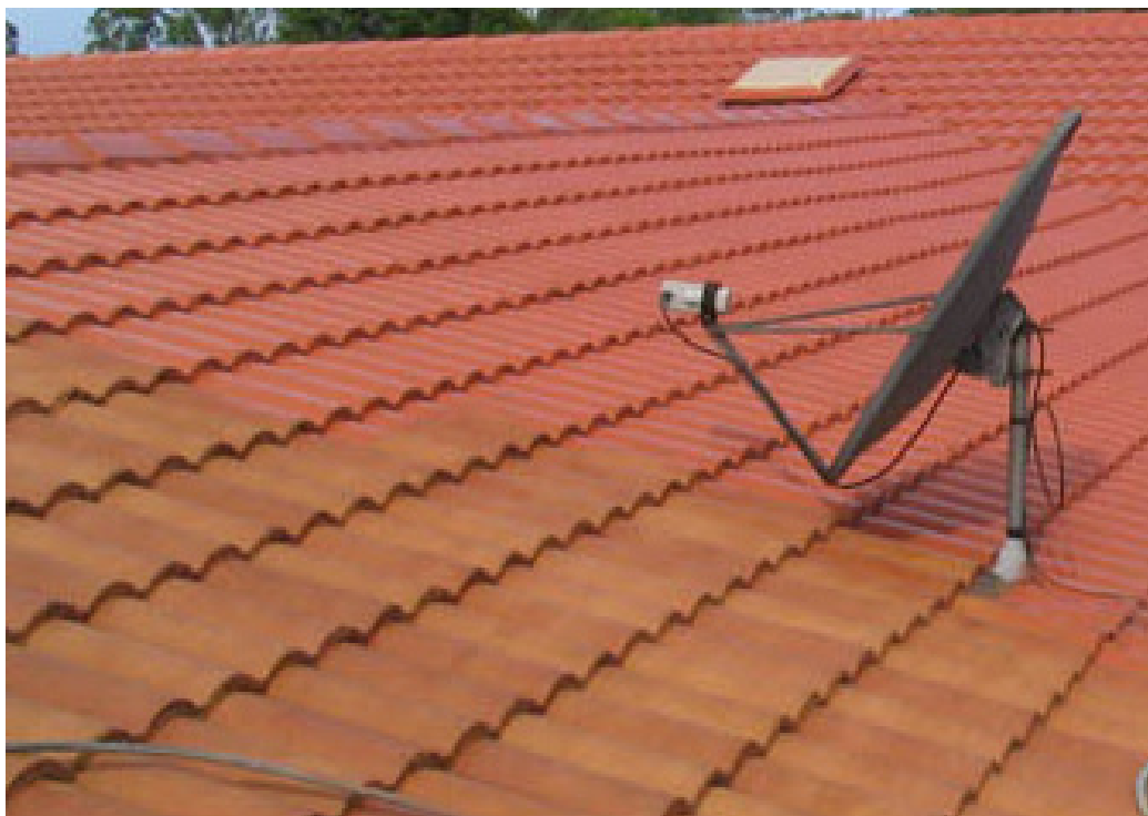
Figura III.5 - Telhado de barro pintado com TELHAL AQUOSO
