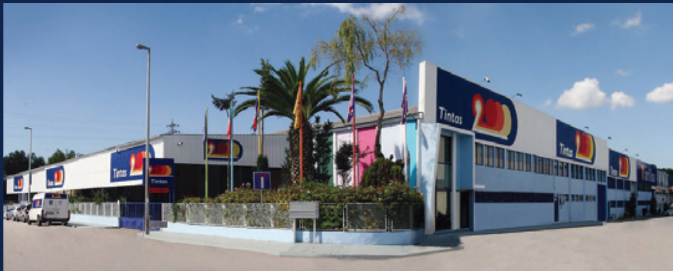
Fábrica de Tintas 2000, S.A.
