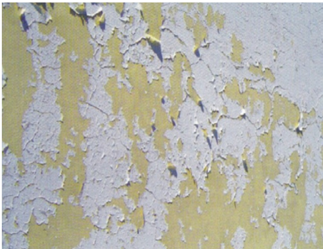
Figura I.13 - Pintura com descasque
