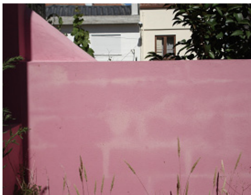
Figura I.1 - Descoloração por ataque alcalino
