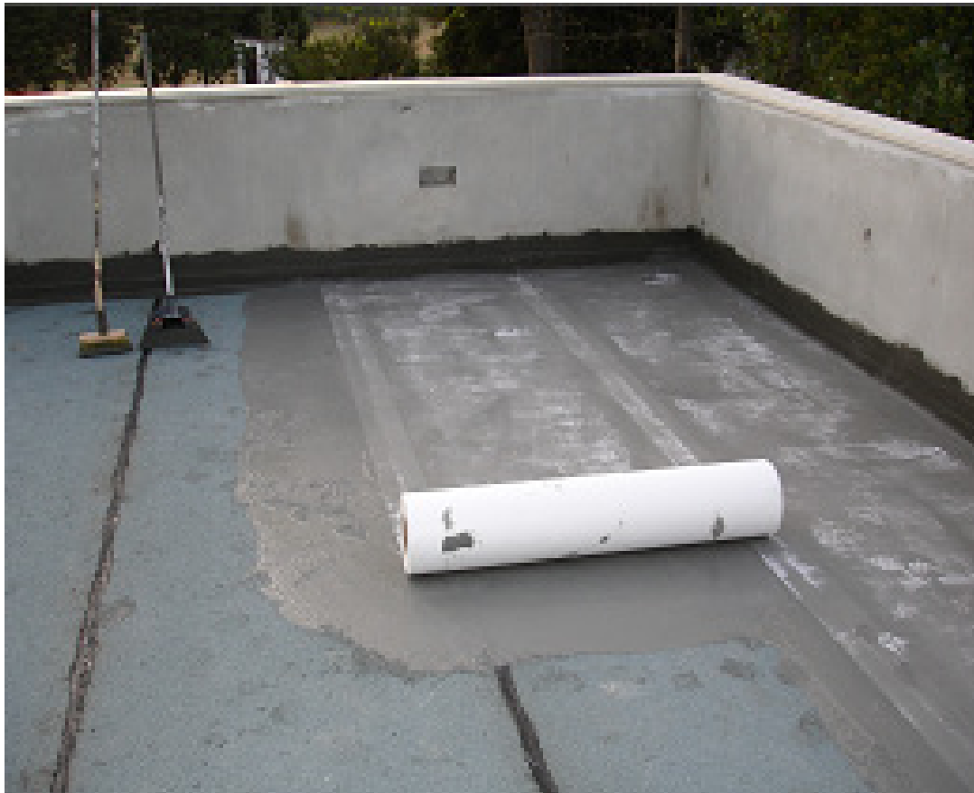
Figura IV.6 - Colocação da rede de fibra de vidro
