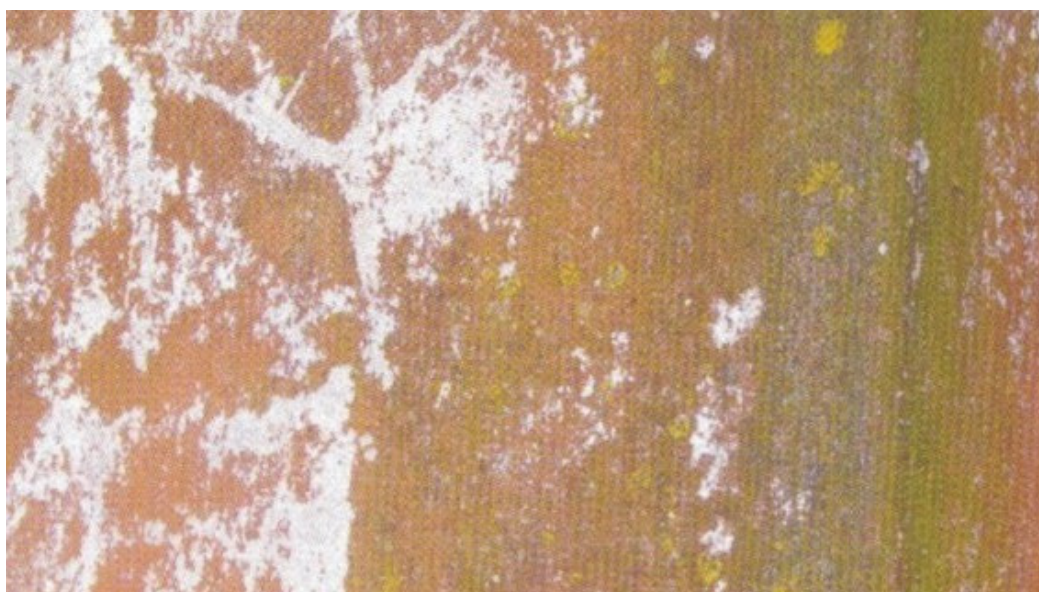
Figura I.4 - Contaminação por algas
