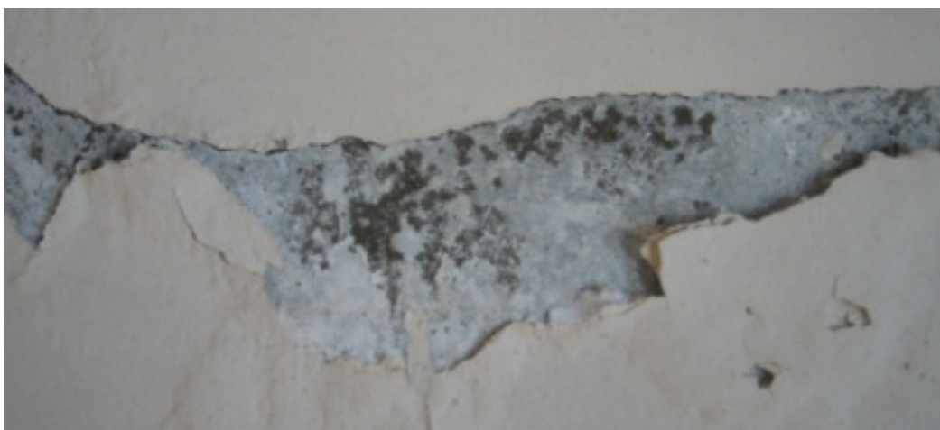
Figura I.11 - Efeitos da água retida no solo (Salitres)
