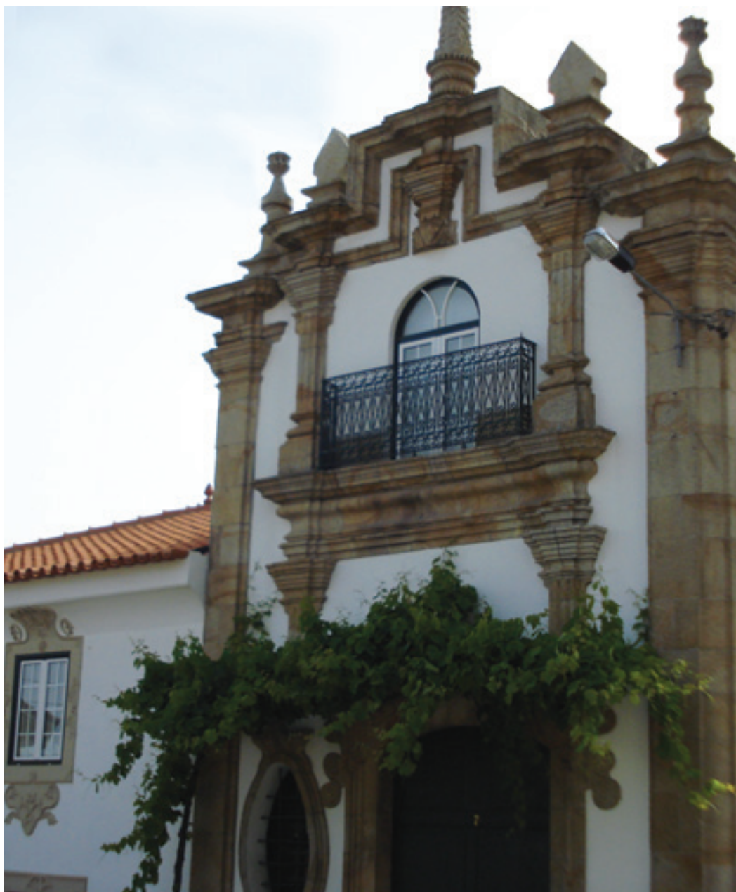
Figura VII.1 - Exemplo de cantarias na edificação tradicional
