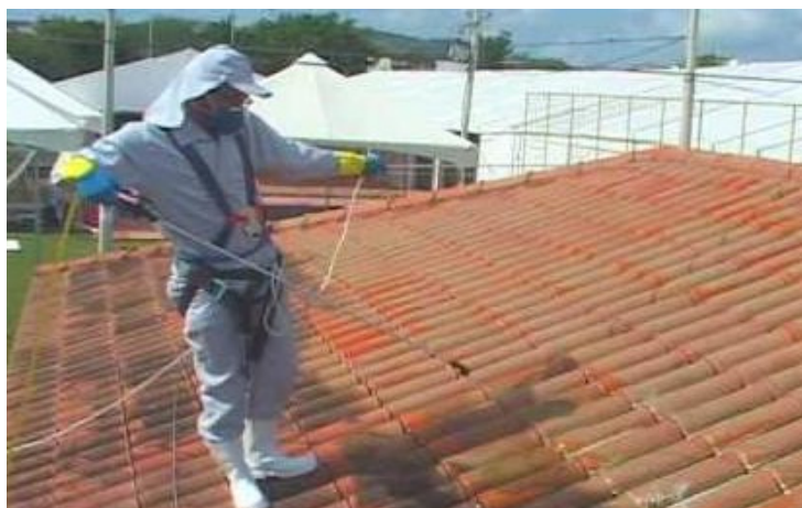
Figura III.2 - Limpeza e desinfectação da superfície
