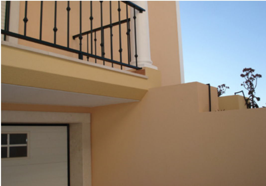
Figura XI.2 - Degradação por efeito da luz
