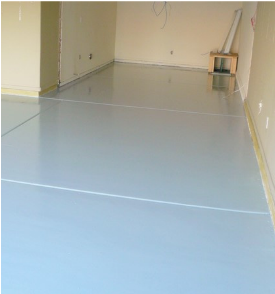
Figura X.6 - Pavimento de uma garagem pintado com Pavipex Aquoso
