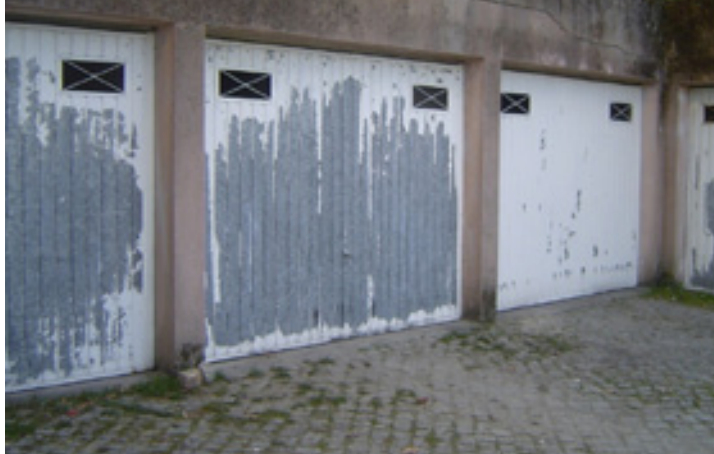
Figura V.2 - Portões com descasque da tinta
