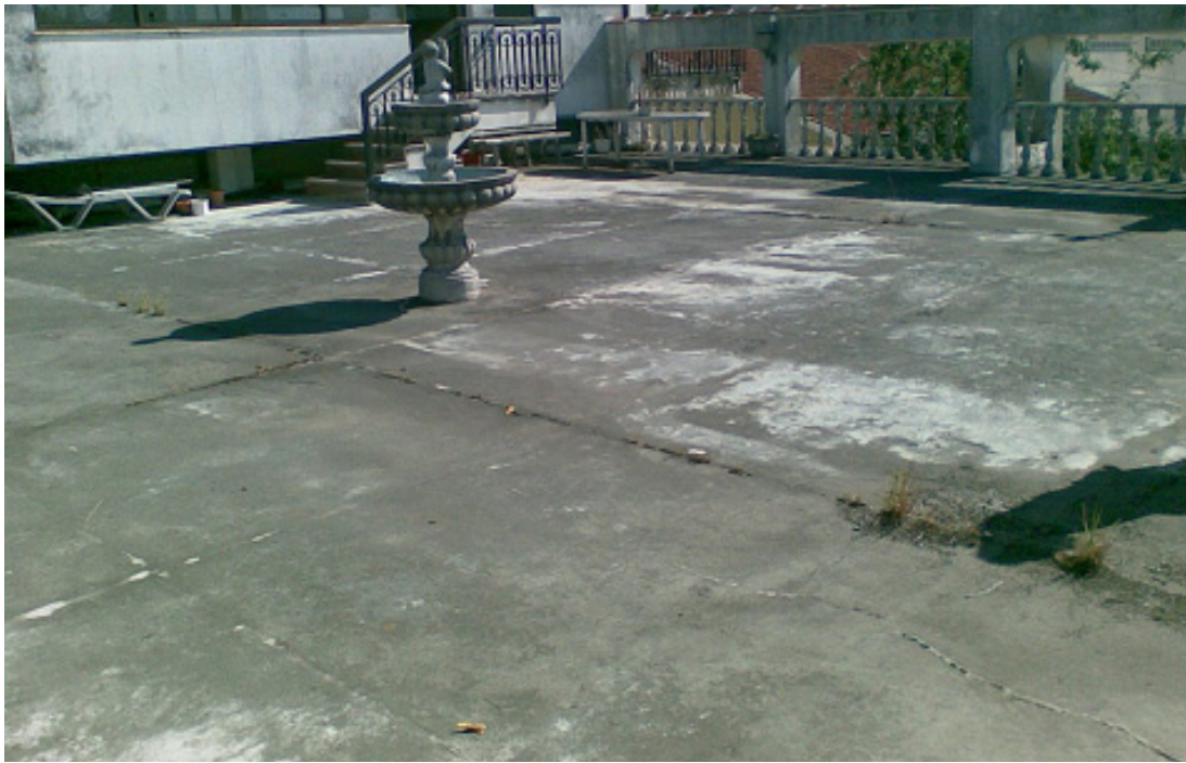
Figura I.9 - Parede nova com microfissuração generalizada
