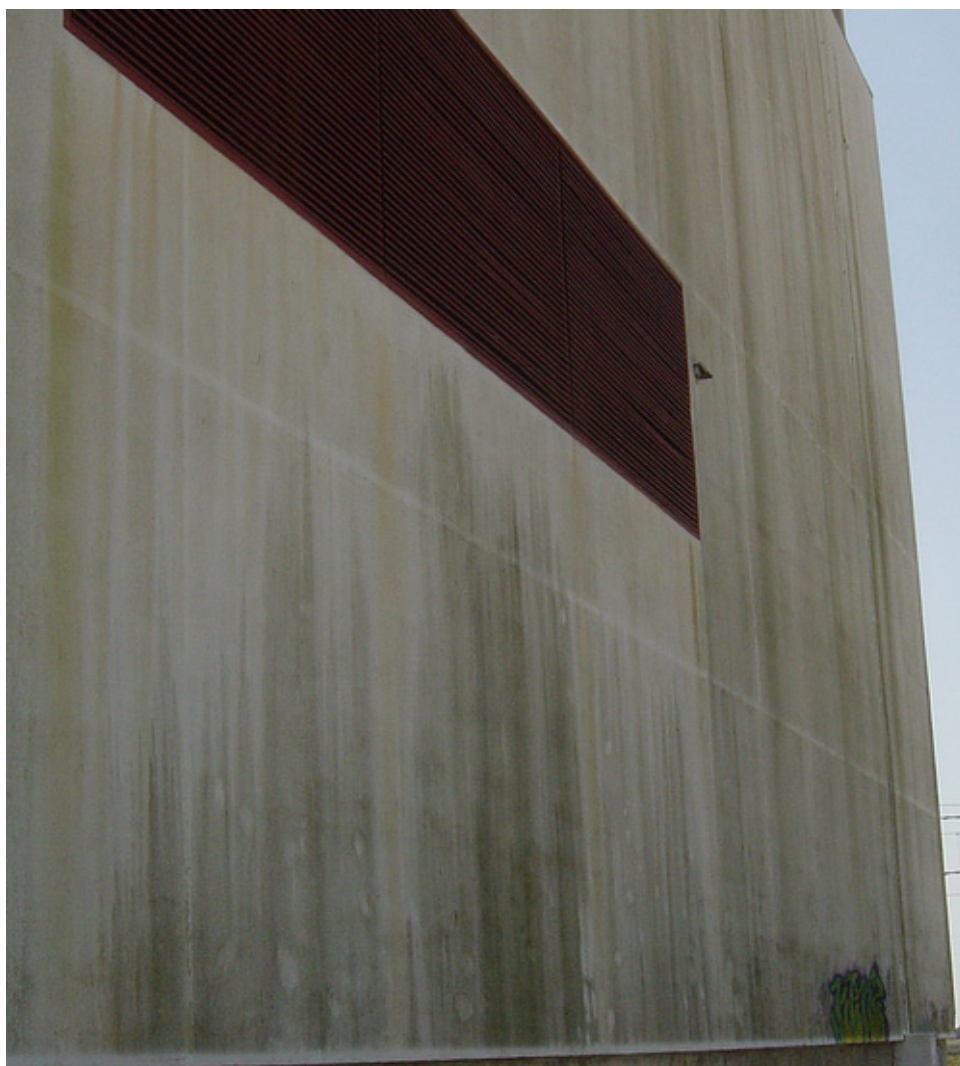
Figura II.7 - Monomassa contaminada com fungos
