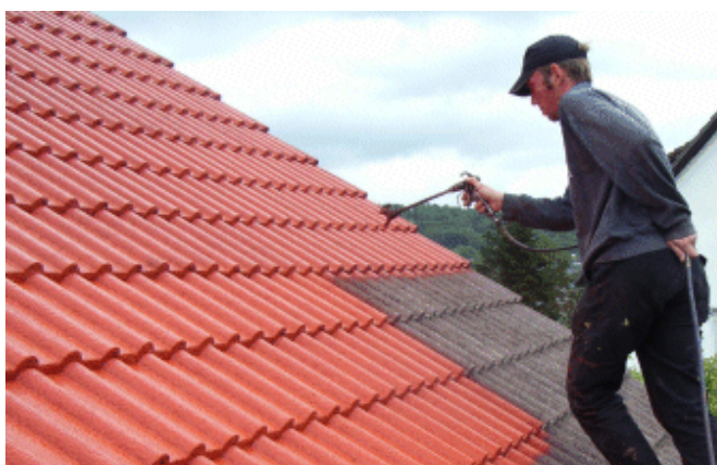
Figura III.6 - Pintura de telhado
