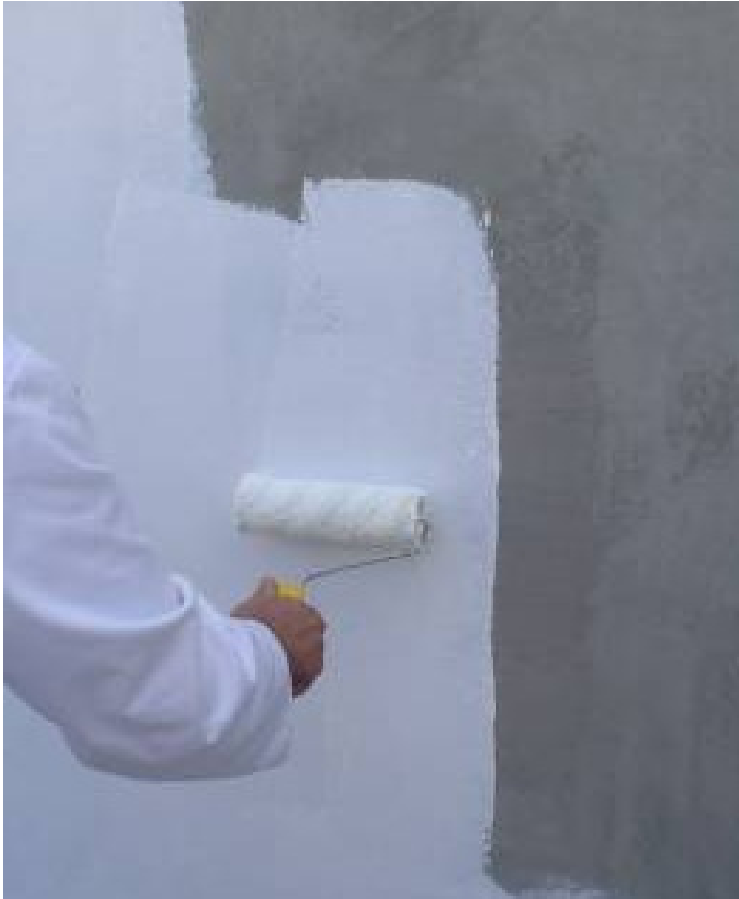
Figura I.17 - Aplicação de um primário para regularizar a absorção diferencial da base
