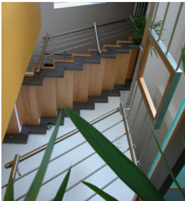
Figura X.2 - Escadaria de madeira envernizada com Aquataco
